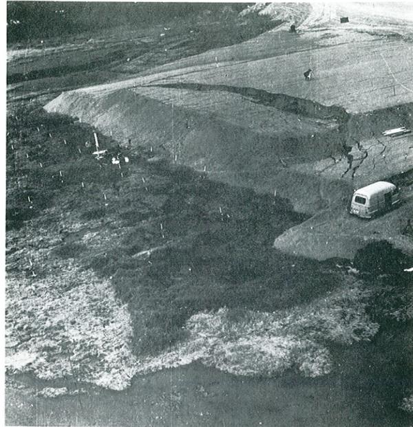
Fig. 35 – Remblai expérimental de Lanester. Expérience de rupture en vraie grandeur.
