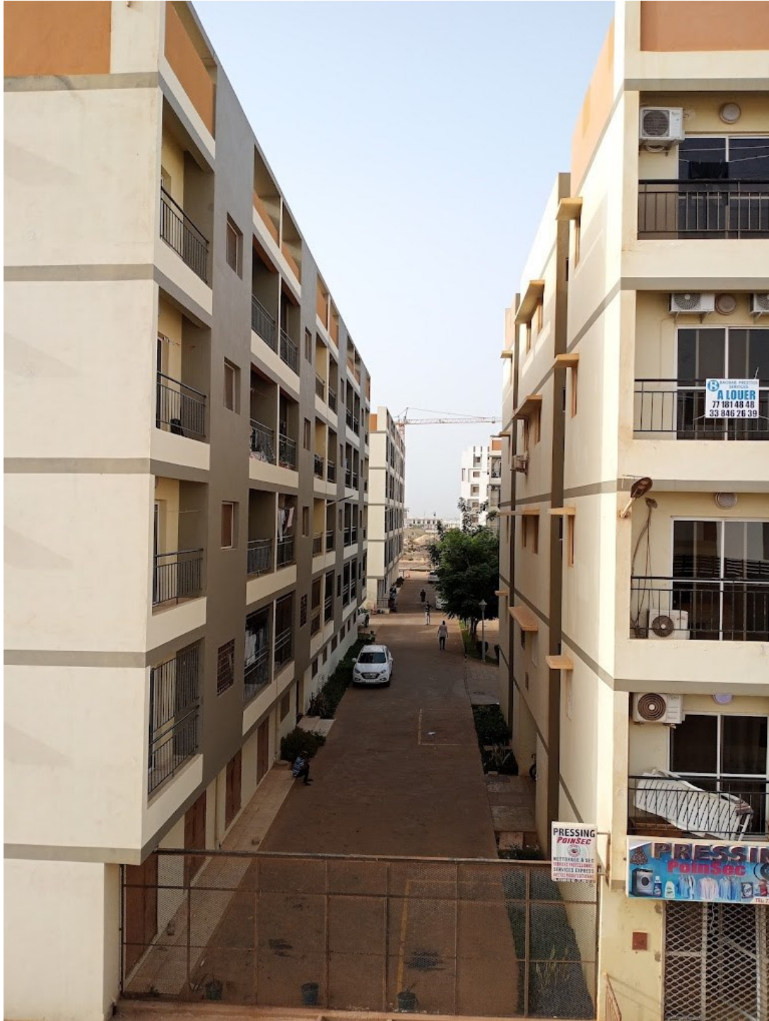
Figure 91. Immeuble d'habitation climatisé dans la cité résidentielle Senegindia Les blocs de climatiseurs envahissent très souvent les façades des immeubles.
