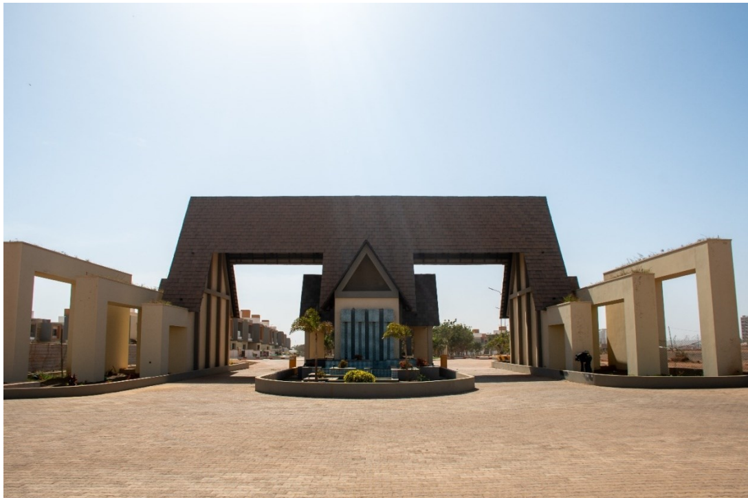
Figure 111. Porte d'entrée principale de la Senegindia Diamniadio City (SD City) L'entrée de la résidence se signale par une guérite. Une barrière amovible contrôle l'accès des véhicules à l'entrée comme à la sortie.
