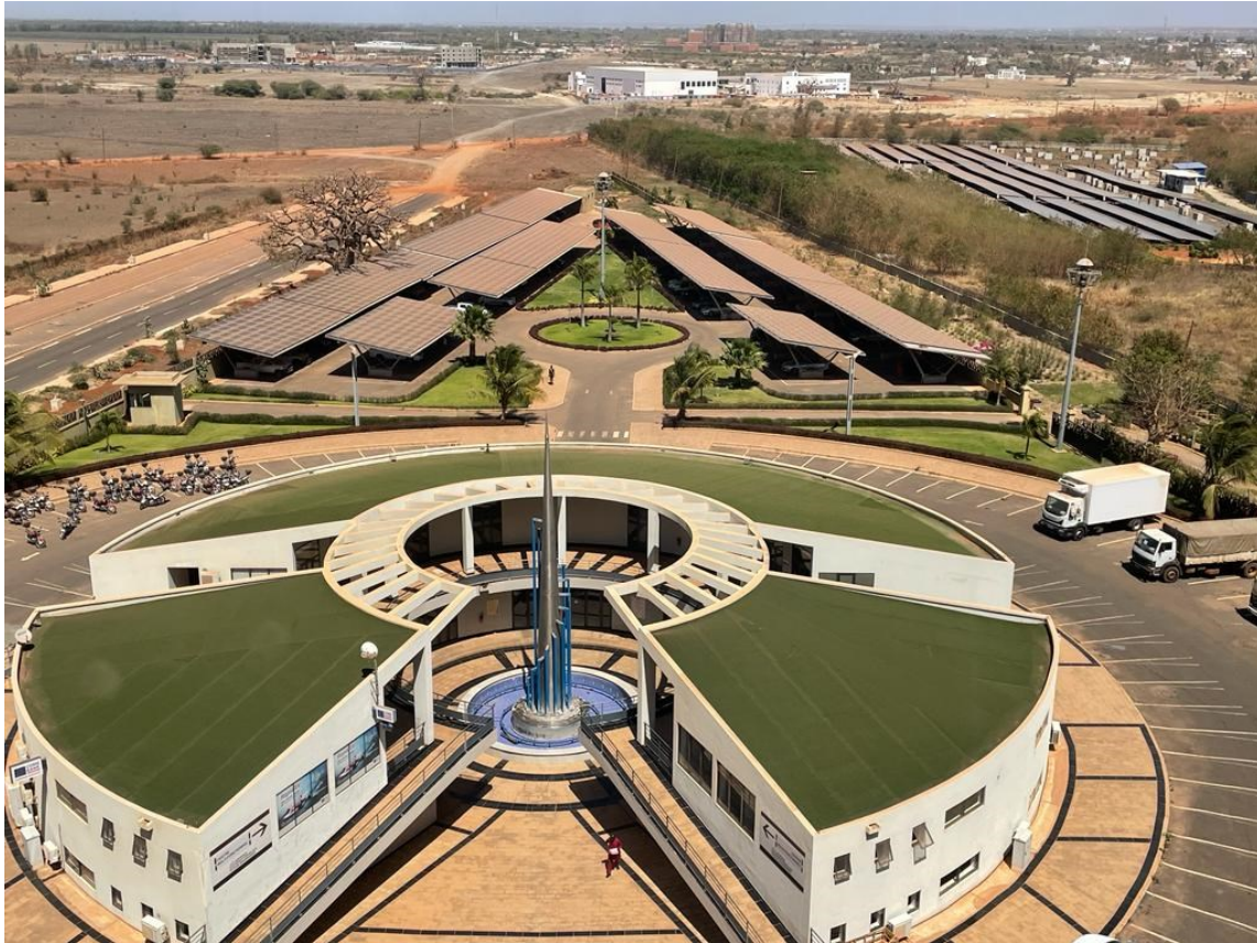
Figure 93. Panneaux photovoltaïques de la sphère ministérielle du secteur 1 Les panneaux servent également de toit pour le parking. À droite de la photo, à l'arrière-plan, les panneaux du centre de conférences.
