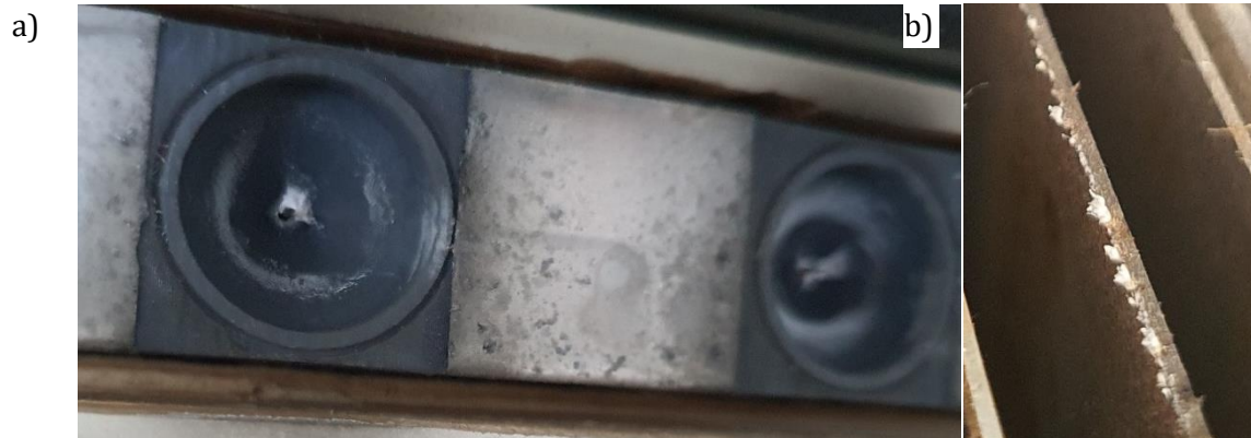
Figure III.21 : Photos des dépôts blancs observés a) sur les aiguilles et b) sur la tranche d'une plaque du collecteur.
