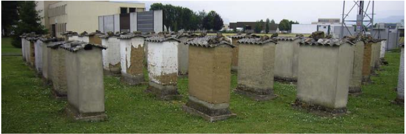
Figure 2.11 : Vue générale des murets sur site, d'après (Bui et al, 2009b)
