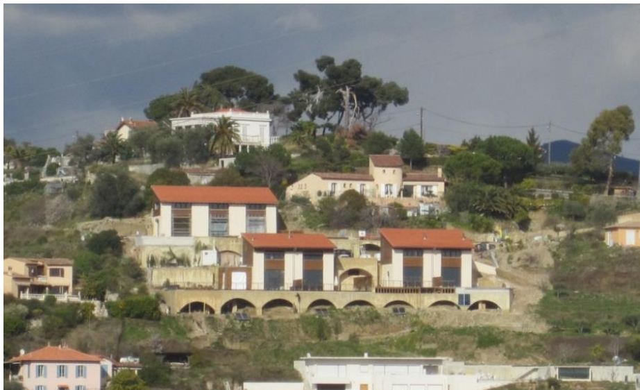
Figure 6.1 : Vue d'ensemble des bâtiments en béton de poudingue du projet « Domaine des Galets » construites en 2014 à Nice
