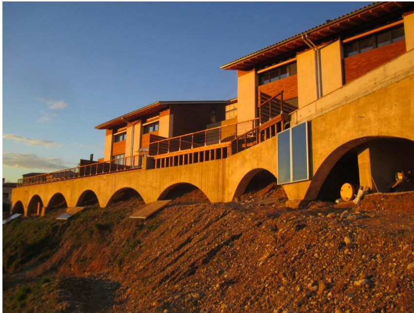
Figure 1.2 : Maisons en béton de poudingue à Nice, construites en 2014, maître d'ouvrage Filiaterre.
