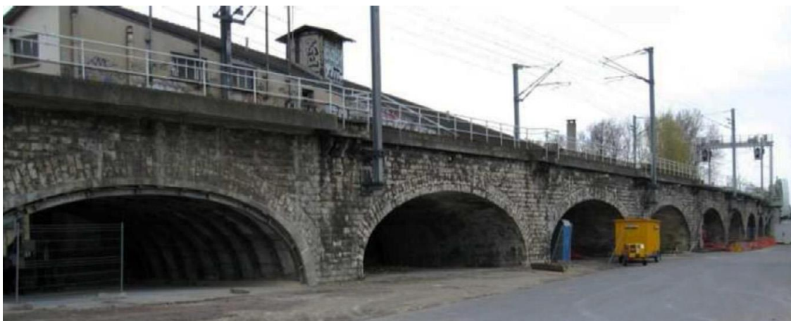
Figure 4.6 : Viaduc en maçonnerie à Paris, France, étudié par (Domede et al, 2013)
