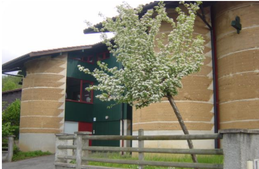
Figure 1.1 : Maison en Pisé moderne construite au cours des années 1980 en région Rhône-Alpes
