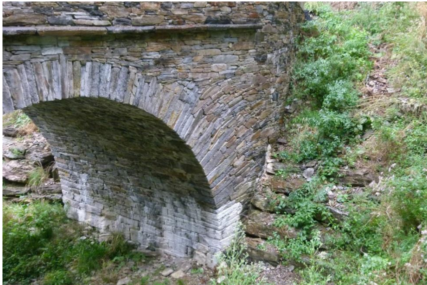
Figure 4.14: Focalisation sur le rein de voûte du Pont de CHALDECOSTE
