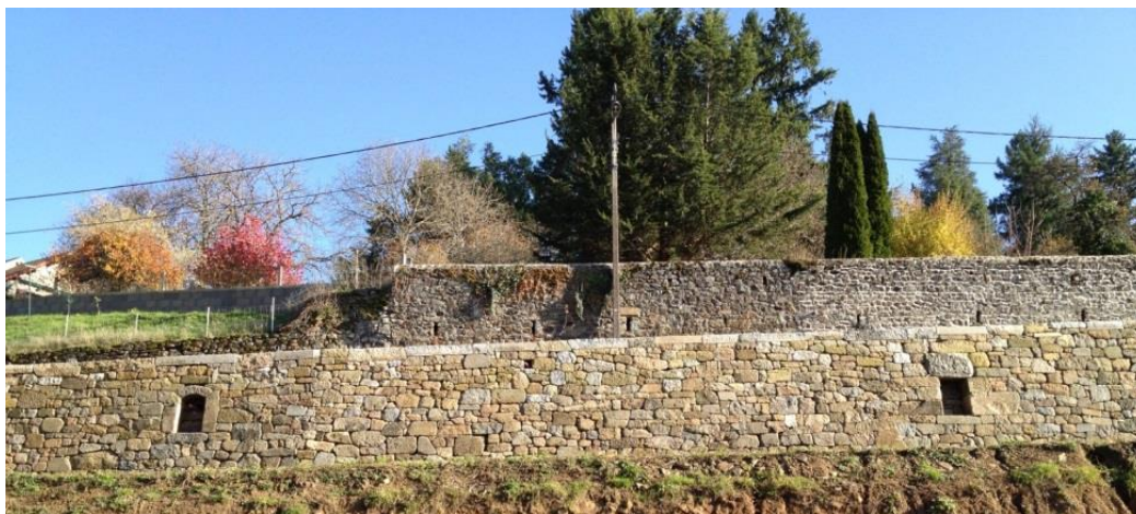
Figure 1.5 : Un mur de soutènement en pierre sèche (granit) construit en 2012 à Felletin ; maître d'ouvrage : mairie de Felletin ; maîtres d'œuvres : entreprises de l'association ABPS (Artisans Bâisseurs en Pierre Sèche)
