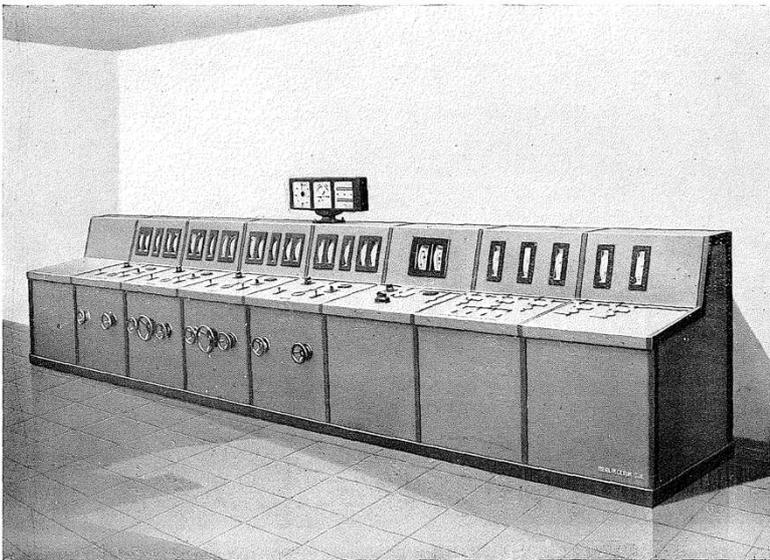
PUITRE DE COMMANDE ET DE CONTROLE AVEC SCHÉMA SYMBOLIQUE TYPE « OBSCUR »
