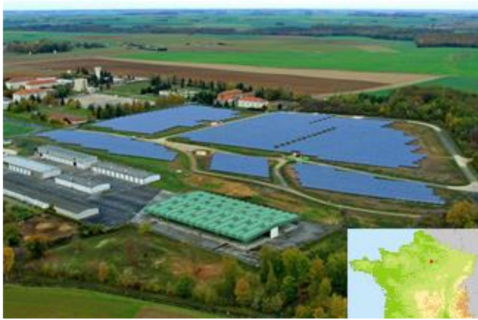
Figure VI.1 : Centrale solaire photovoltaïque de Sourdun.
