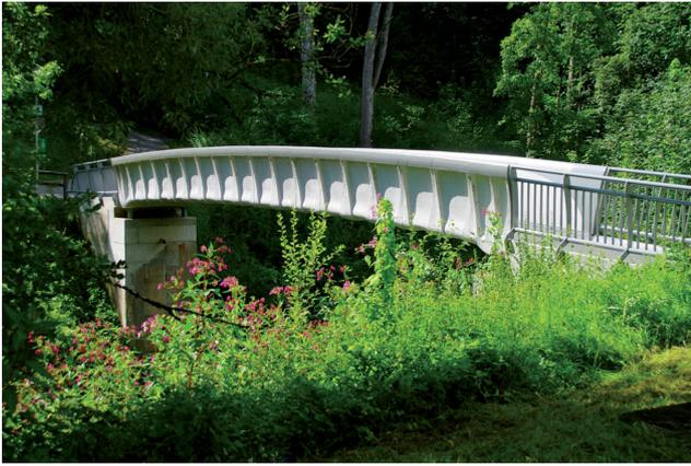
(a) Pont de 17 mètres avec les coques de TRC de 30 mm d'épaisseur [23]
