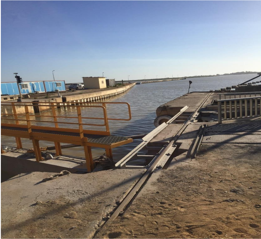
Figure 85 : Barrage de Diama, Photo KA. S, 2021
