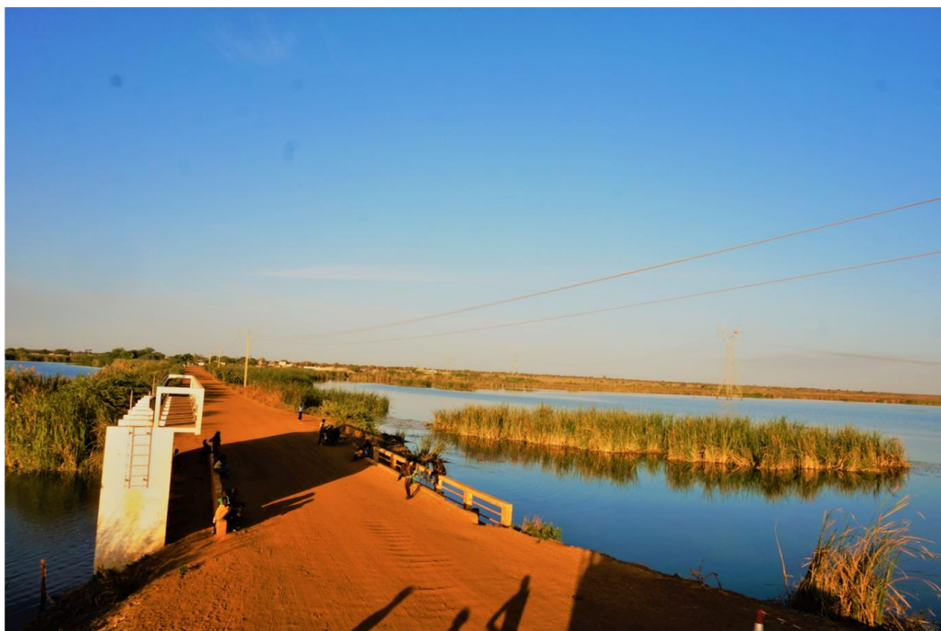
Digue de K M SARR Photo KA. S (janvier 2019)
