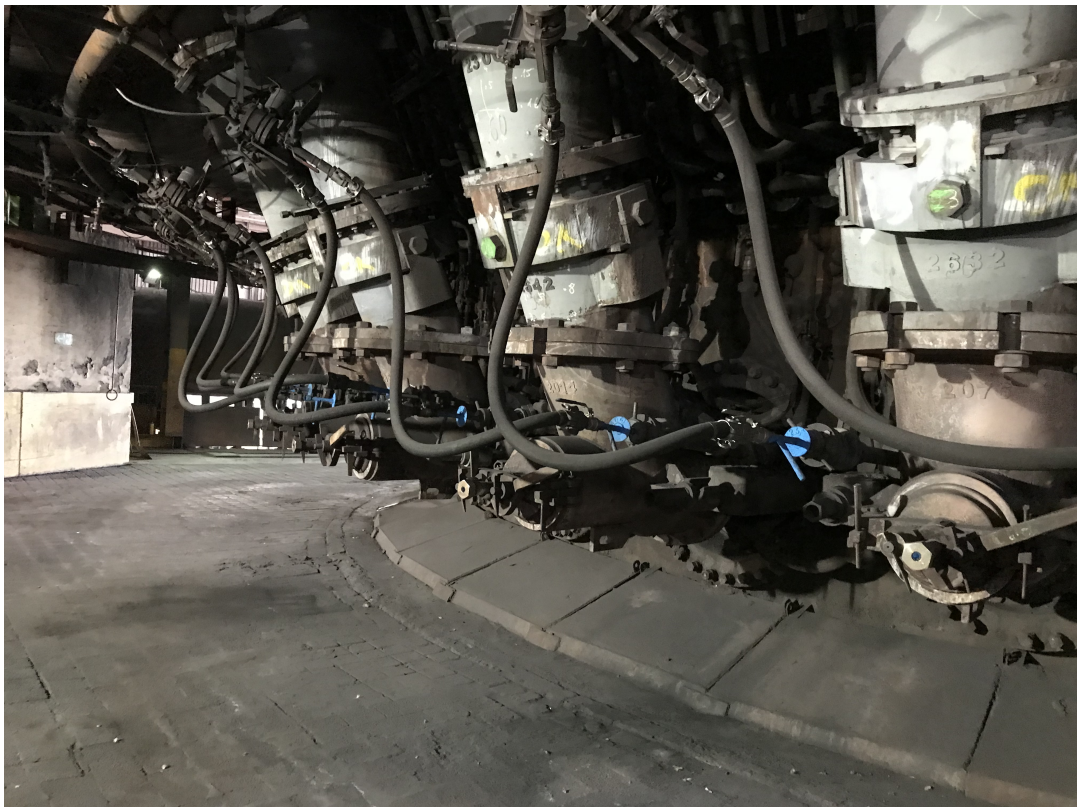
FIGURE 5.3 : Photo de tuyères où de l'air chaud est injecté (ArcelorMittal).
