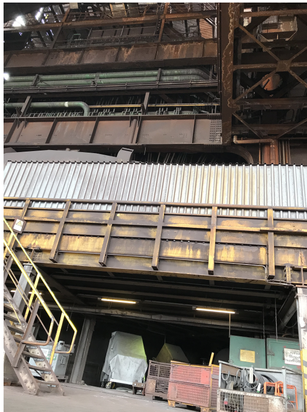
FIGURE 6.1 : Photos de notre détecteur sur le site d'un haut fourneau (ArcelorMittal). Il est bâché pour être protégé de toutes les poussières et autres substances volatiles.
