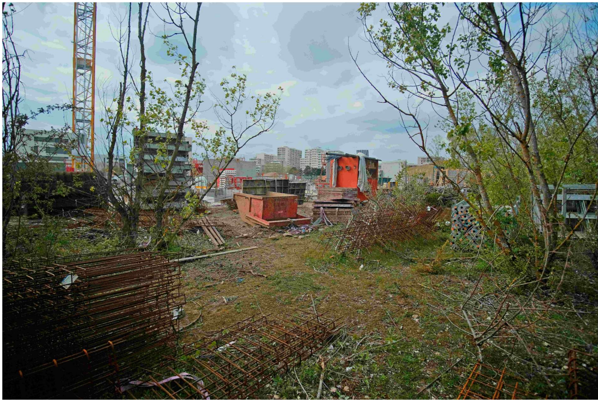
Figure 5-5 : L'extension urbaine à l'œuvre en 2022 pour la production de logements sur des espaces forestiers, ici le bois de Sermenaz à Rillieux la Pape sur la Métropole de Lyon. Photographie Thomas Boutreux.
