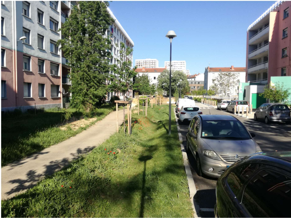
Figure 1-37 : Aménagement d'une noue d'infiltration en habitat collectif, opération de renaturation du bailleur social Est Métropole Habitat (Villeurbanne). Photographie Thomas Boutreux.
