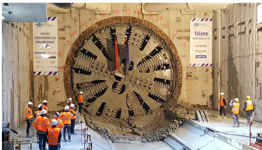
Figure 1-10 : Tunnelier "Yolène" à la fin du creusement du prolongement de la ligne 14
