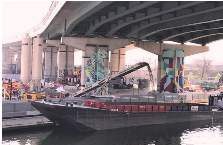
Figure 1-11 : Remplissage d'une barge avec les déblais du puit du canal de St Denis de la ligne 16 à Aubervilliers (93)
