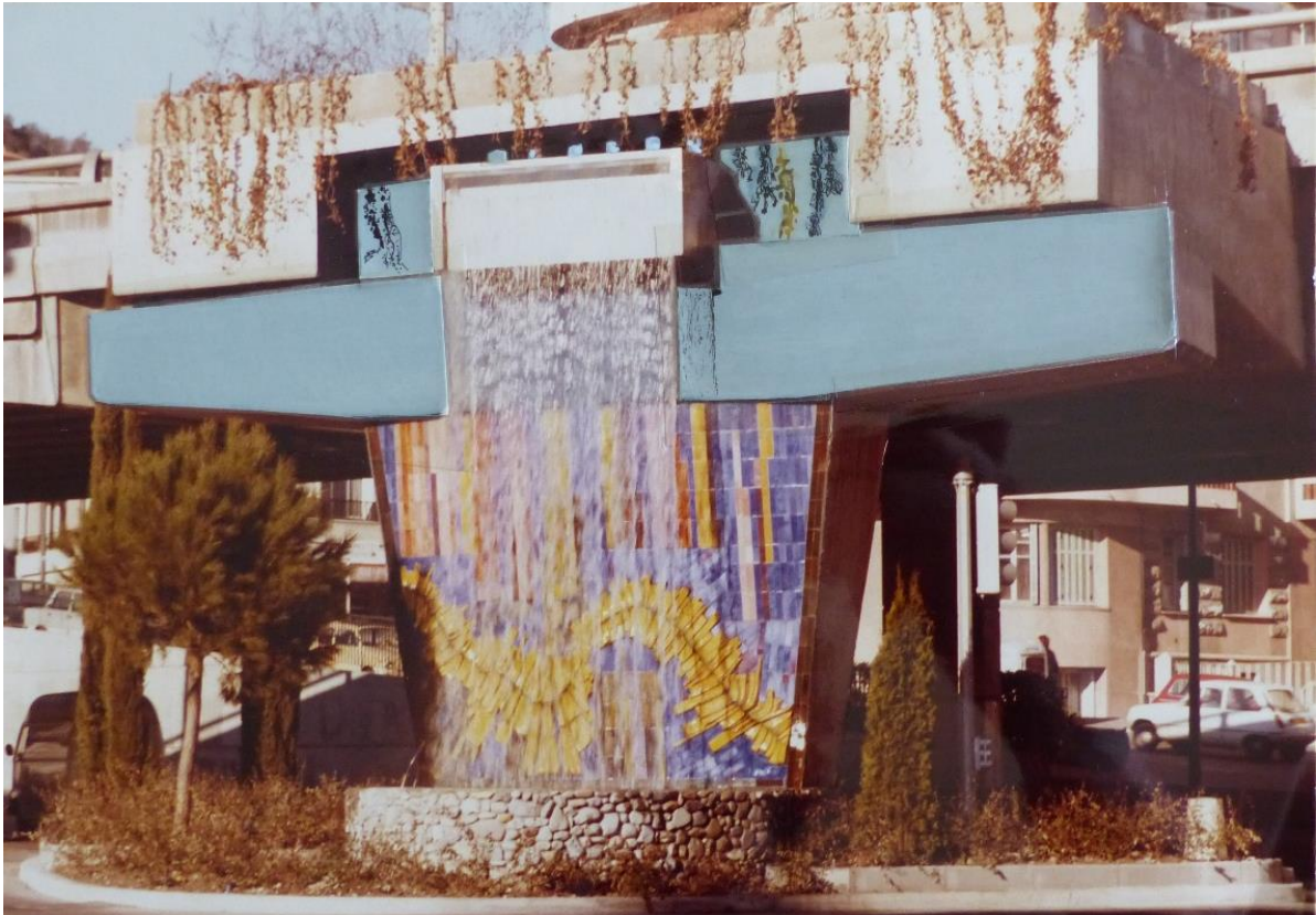
Figure 40. Pilier sud de la place Saint Philippe avec sa fontaine. AM, 606W61.
