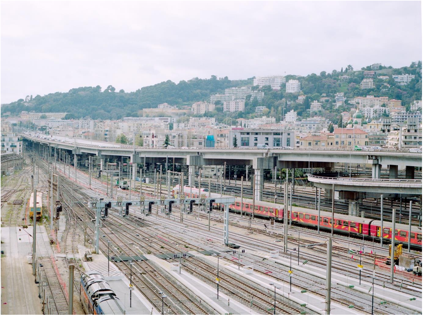
Contournement de la gare ferroviaire vu depuis le sud, et échangeur Saint Étienne (rue abbé Grégoire) à droite de la photographie. Photographie d'Amandine Mohamed-Delaporte, 2021.
