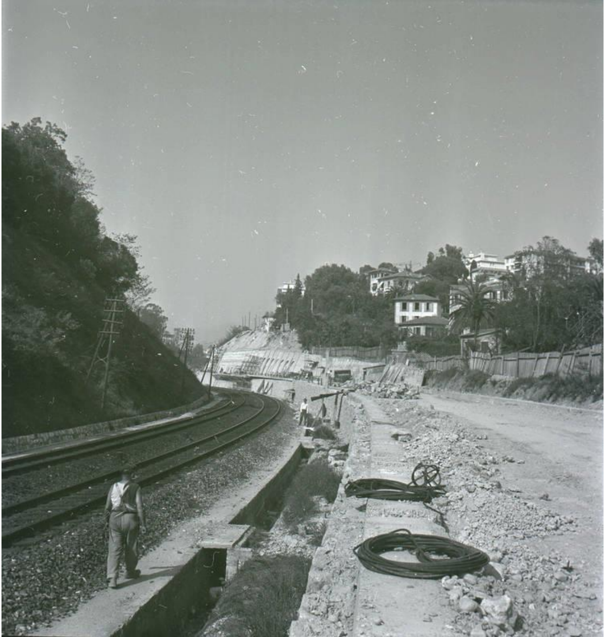
Construction du premier tronçon, Magnan-Saint Philippe (1962). AM 1064W322.
