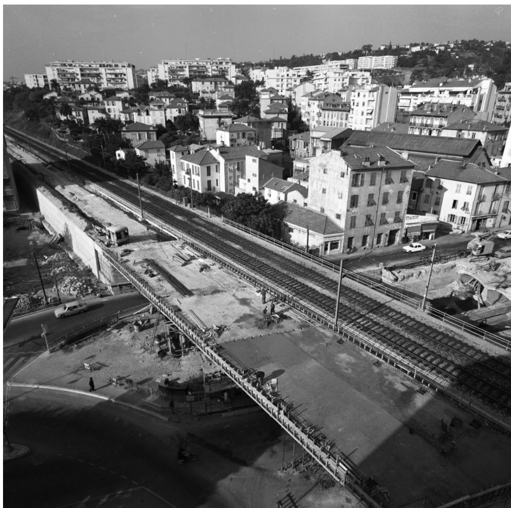
Figure 25. Construction du viaduc de Magnan. AM 860W1968.
