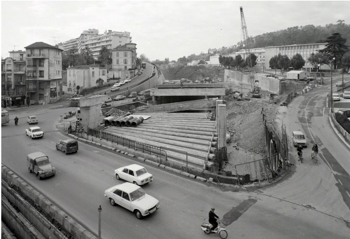
Figure 32. Recouvrement de la voie ferrée à la hauteur de la place Saint Philippe. AM 860W1972.
