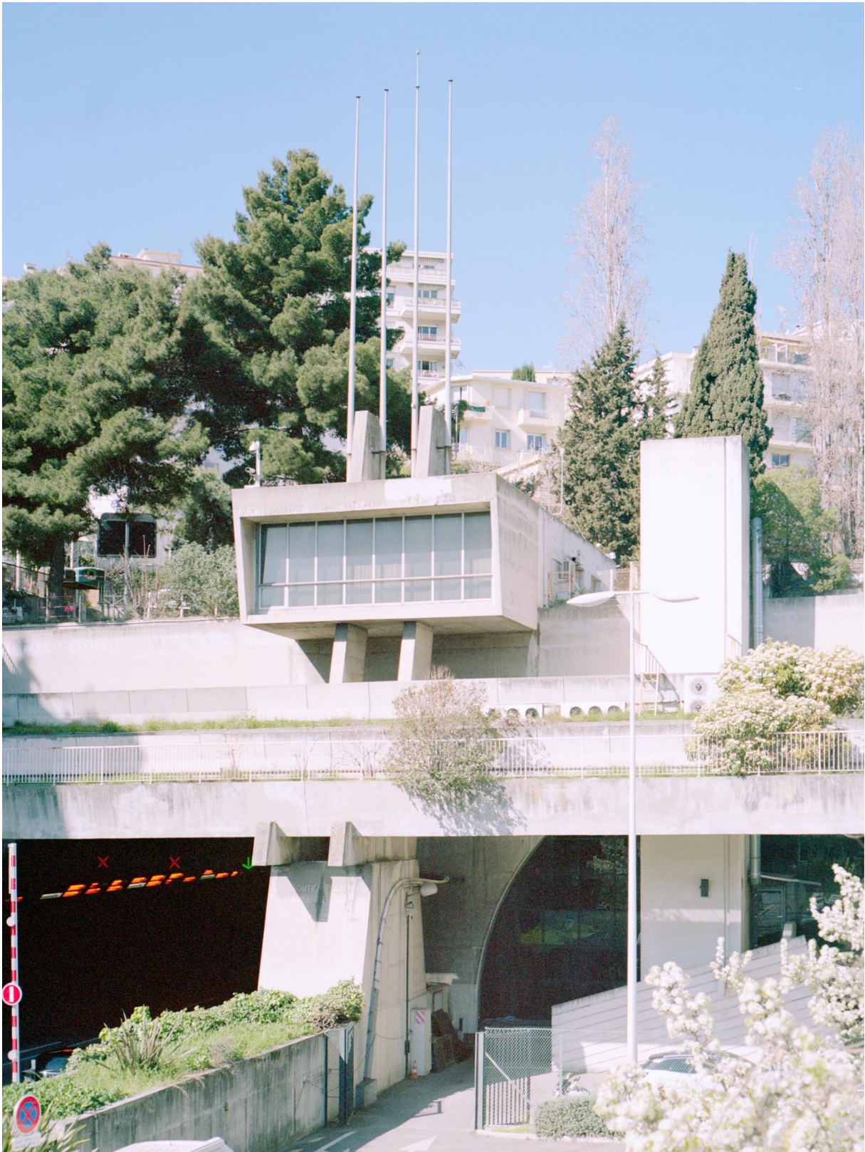
Ancien centre de contrôle de la circulation niçoise. Le centre se trouve toujours à l'entrée est du tunnel Malraux. Photographie d'Amandine Mohamed-Delaporte, 2021.
