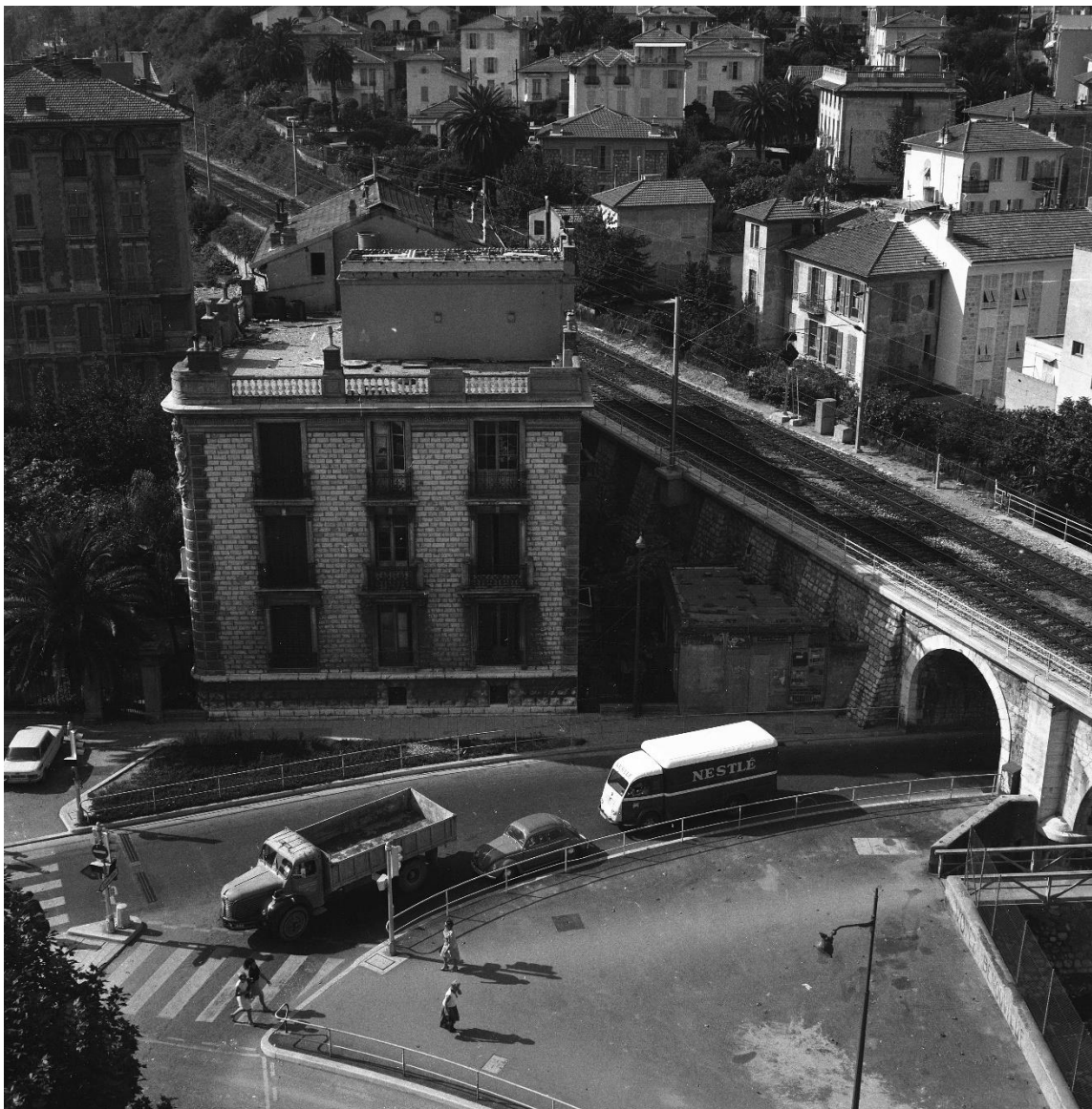
Figure 23. Pont de la voie ferrée traversant le Magnan, avant la construction de la voie rapide. AM860W1968.
