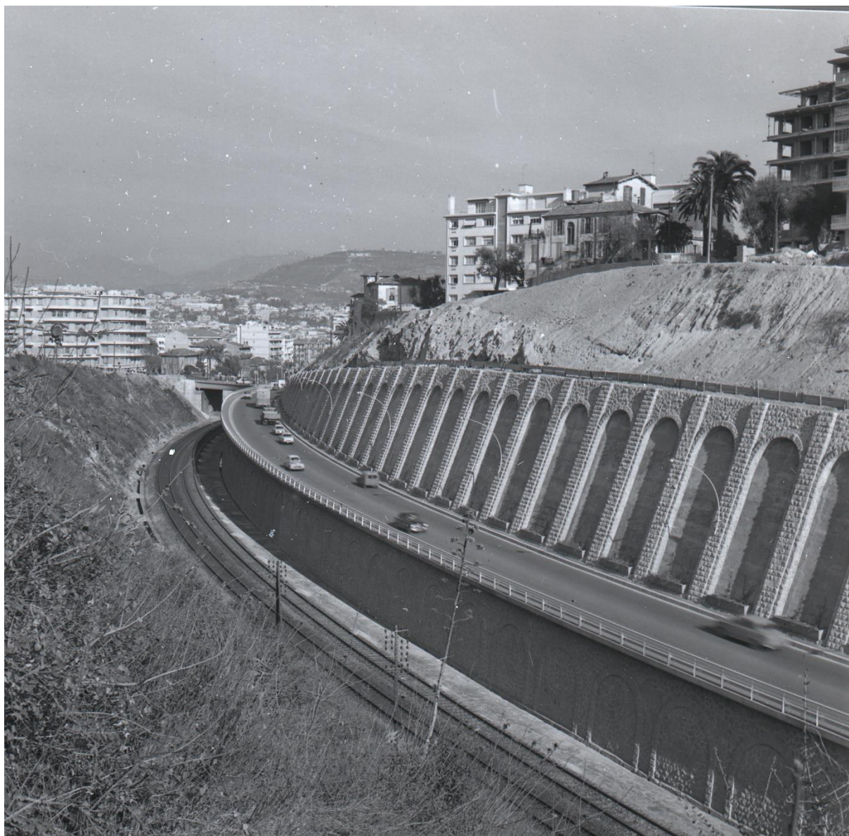
Figure 22. Tronçon Magnan-Saint Philippe après les travaux. AM 1064W323.
