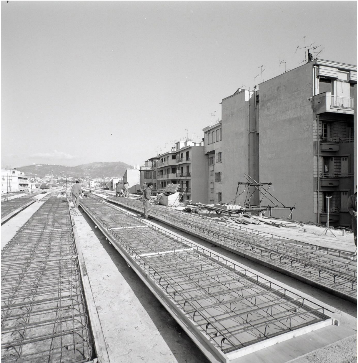
Photographie du viaduc surplombant le centre-ville niçois. Nous pouvons voir à l'arrière-plan les collines de l'est de Nice. AM 860W1972.
