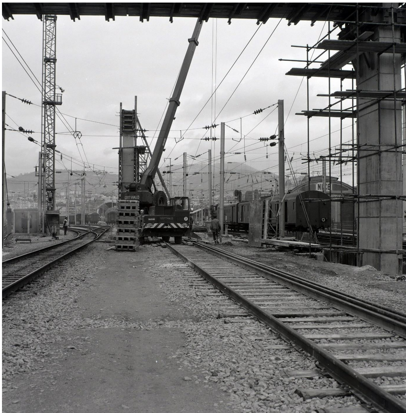
Photographie de la construction du viaduc au-dessus de la voie ferrée prise en 1972. AM 860W1972.
