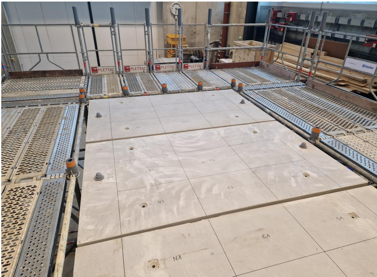
Figure 102 : Marquage au sol des dalles
