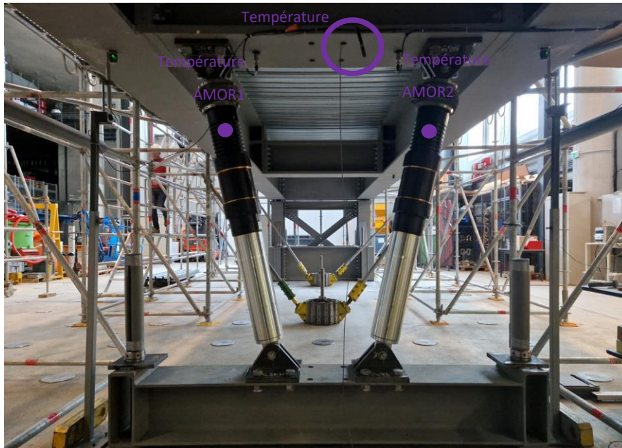
Figure 111 : Positionnement des sondes de température
