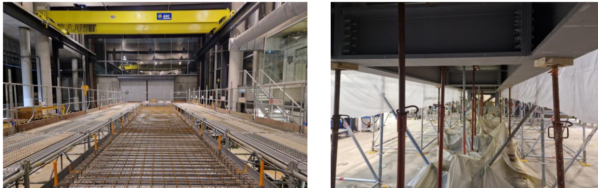
Figure 90 : Ferrailage le 29/11/2022 et étaielement de la dalle et des poutres
