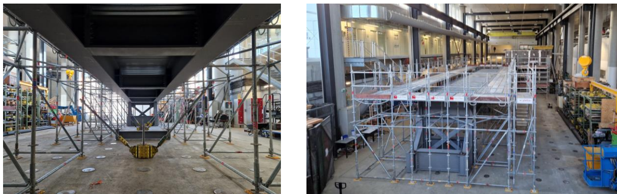
Figure 89 : Mise en place des échafaudages du 21/11 au 25/11/2022
