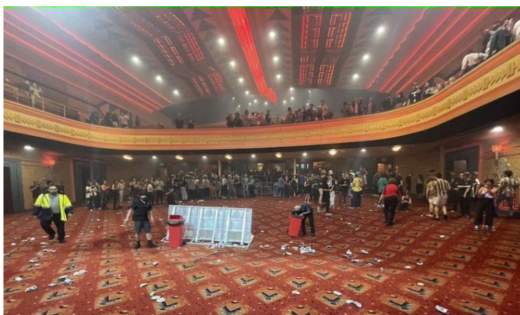
Figure 245 : Affaissement d'un plancher dans une salle de concert, Sydney, 2022, [53]
