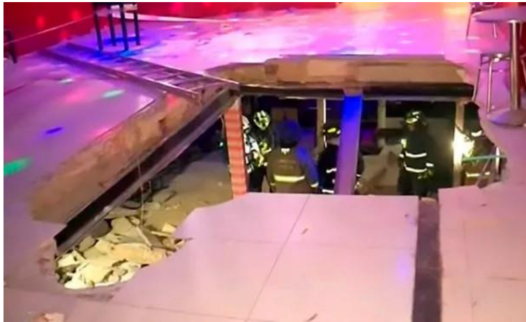
Figure 243 : Effondrement du plancher d'un bar, Bogota, 2019, [52]
