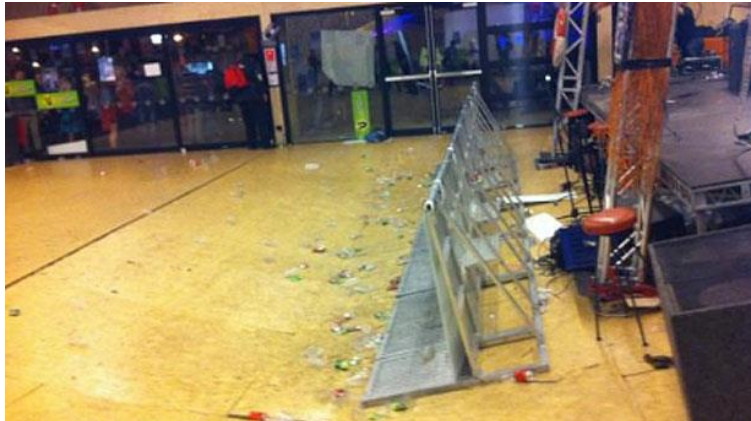
Figure 237 : Affaissement devant la scène d'un plancher, Nouvelle-Zélande, 2012, [48]
