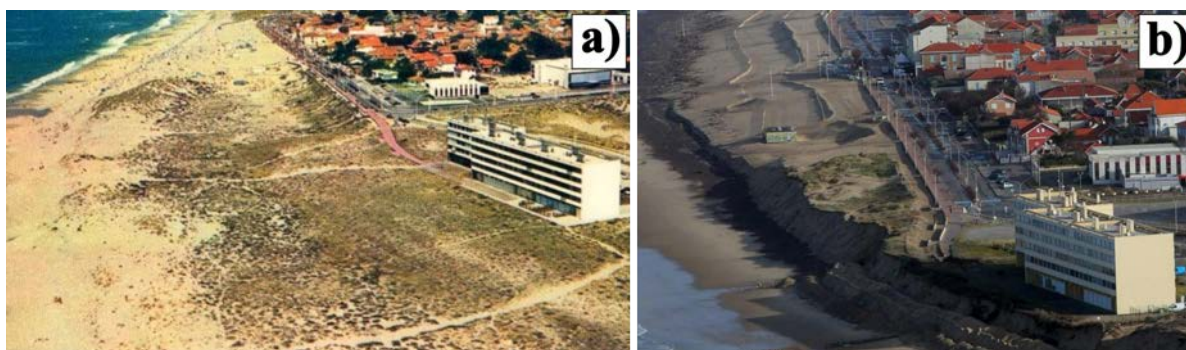
FIGURE 2.19 – Photographies du bâtiment Le Signal au sud de Soulac-sur-Mer (a) dans les années 70 (source : inconnue) et (b) en 2015 (@L.Theillet).
