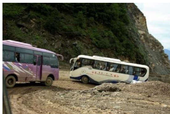
Photo 15 : route pendant travaux en 2011
