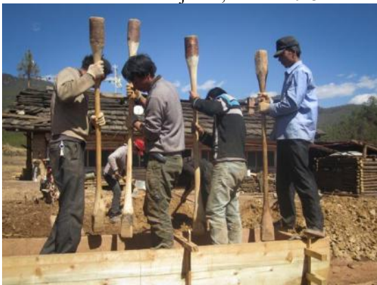
Photo 59 : Tasseurs de terre, maisonnée des Wz, maisonnée des Lijiazui, février 2013.
