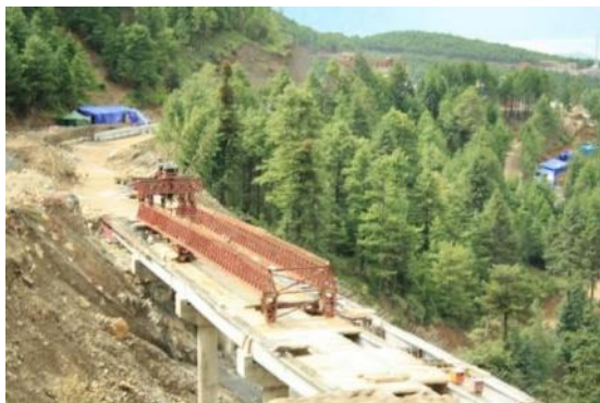
Photo 14 : travaux à l'entrée du lac Yunnan 2011
