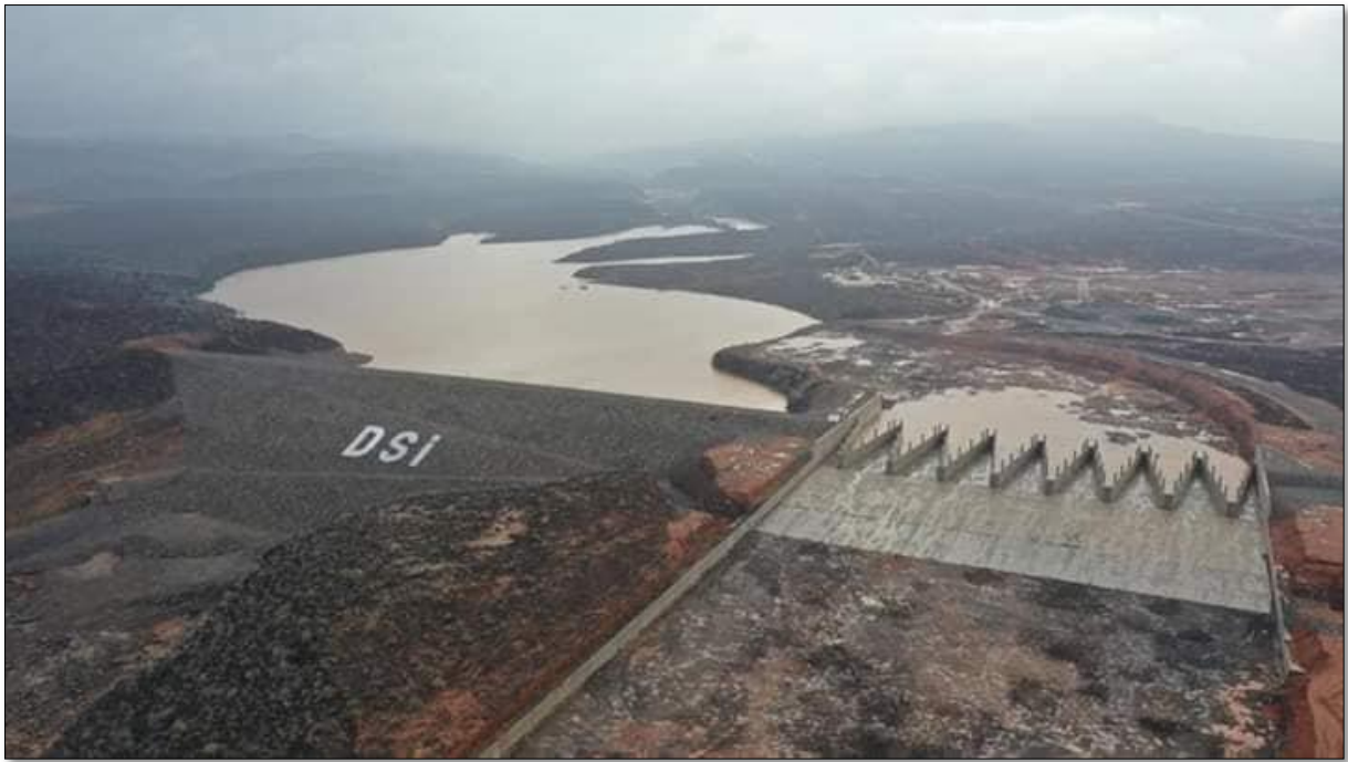
Figure 78: Image aérienne du Barrage de l'Amitié lors de l'évènement de 2019, le barrage a retenu 10 millions de m 3 d'eau (Source : Radio Télévision de Djibouti)
