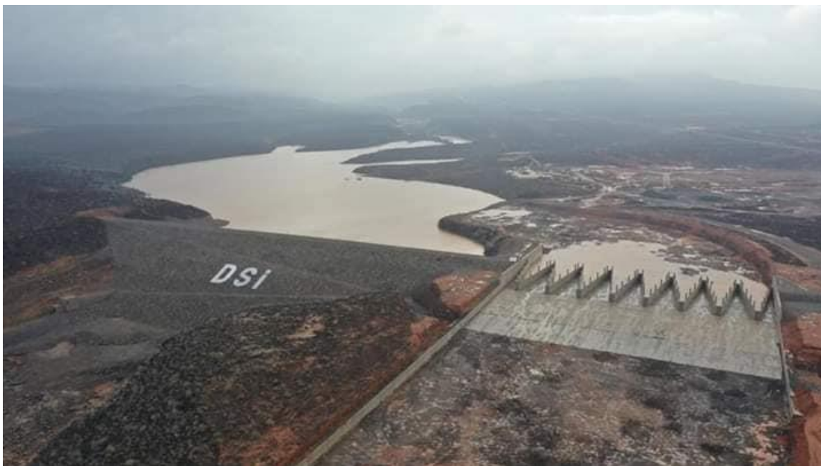
Figure 12: Photographie aérienne du Barrage de l'Amitié à Oueah (Source : Radiotélévision de Djibouti)
