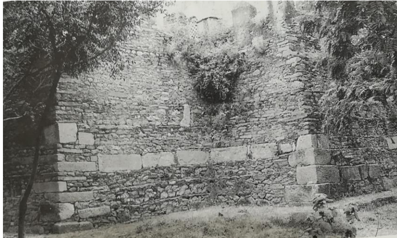
Fig. 84- Immagine del podium di Maryam Tyon. In evidenza l'angolo S-E con la presenza dei conci angolari
