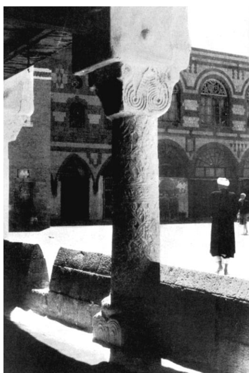
Fig. 138- Colonna con decorazione vegetale stilizzata con capitello ribaltato alla base del sottogruppo 2.b collocato nella parte orientale del cortile della Grande Moschea di Şan'ā' (Garbini 1970, tav. IX) [Passarelli 2008, Tavole, fig. 39]
