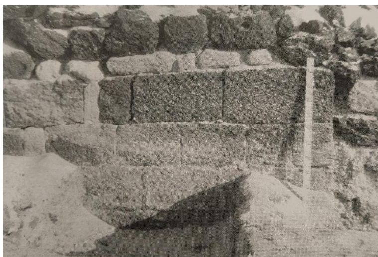
Fig. 186- Immagine della muratura dell'« edificio anteriore »
