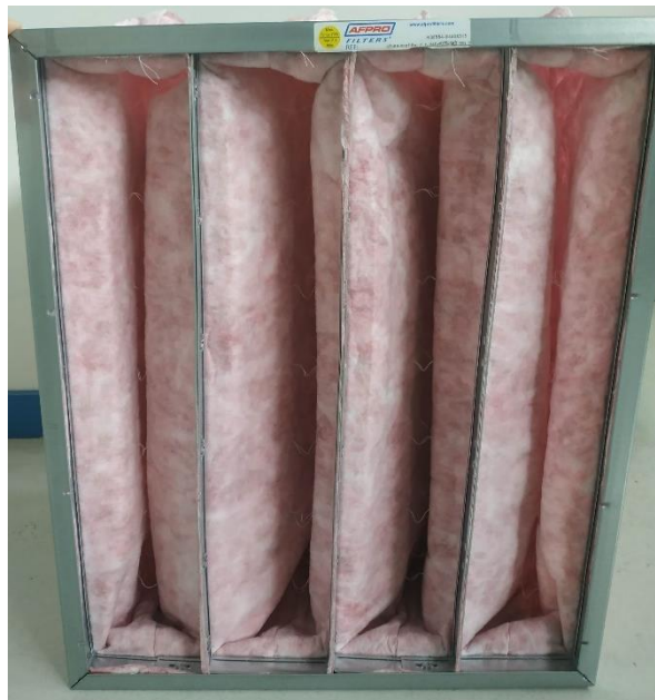
Figure 2-8 : Photographie d'un filtre à poches neuf mis en œuvre dans la CTA étudiée
