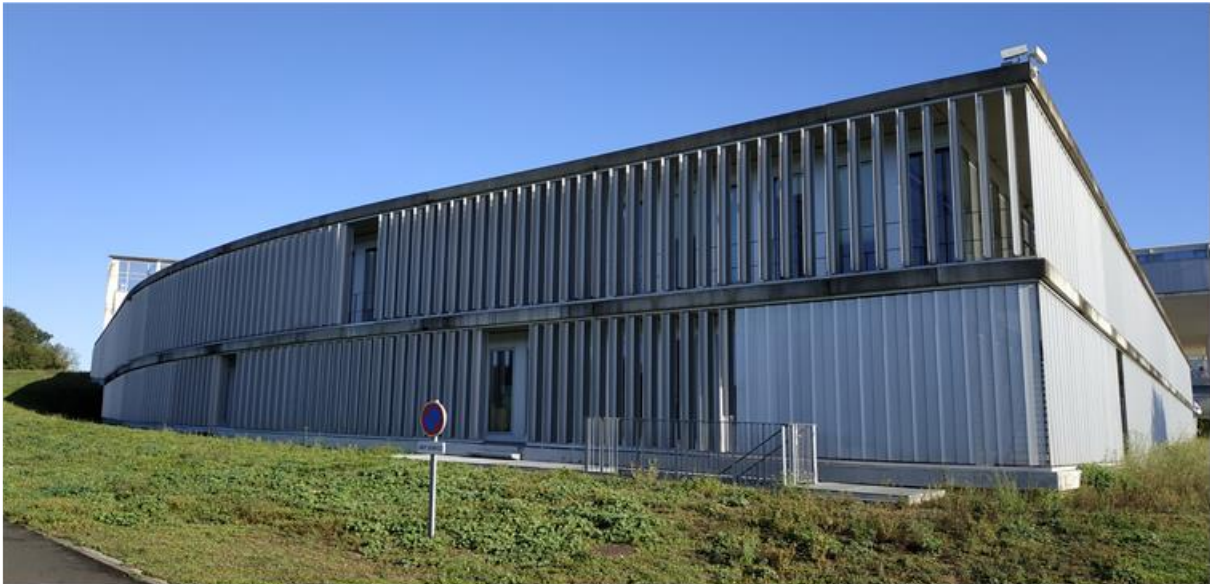
Figure 2-5 : Photographie du Bâtiment d'IMT Atlantique Nantes hébergeant la CTA
