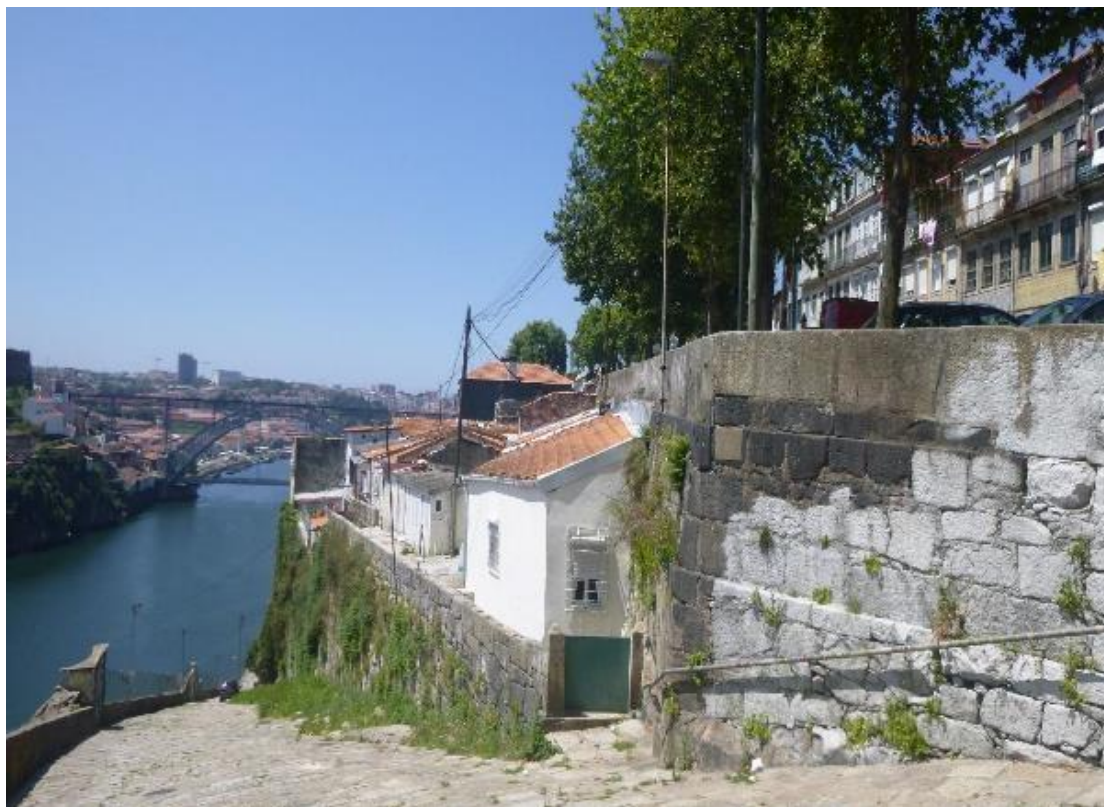
Figure 75 – Vue depuis le haut de la Calçada das Carquejeiras. Source: Photo prise par AR Albuquerque, 2021
