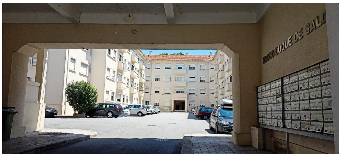
Figure 724 – Tunnel d'accès à la cour et au bâtiment situés à l'intérieur du bloc dans la Rue Duque de Saldanha, freguesia du Bonfim, Porto. Source : Photo prise par AR Albuquerque, 2021.
