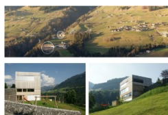
Figure 99. Intégration dans le paysage alpin de la communes de Sankt Gerold du centre communal (1) et de la sale d'équitation (2), et vues extérieures du Centre communal de Sankt Gerold, par Cukrowicz Nachbaur Architekten ZT GmbH, 2008..... 479 Crédit photo du haut : Wikimedia Commons. Crédit des photos en dessous : 1- 2- Böhringer Friedrich, Wikimedia Commons.
