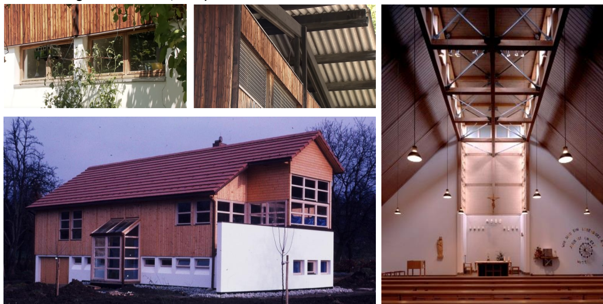
Figure 90. Constructions de Rudolph Wäger (maison Linder à Rankweil, 1965 ; maison à Bregenz, 1982 ; église de Dornbirn, 1999).
