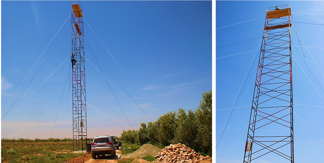
Figure II. 11 : Photos prises lors de l'installation de la tour illustrant la structure des échafaudages qui construisent la tour, ainsi que les haubans de stabilisation
