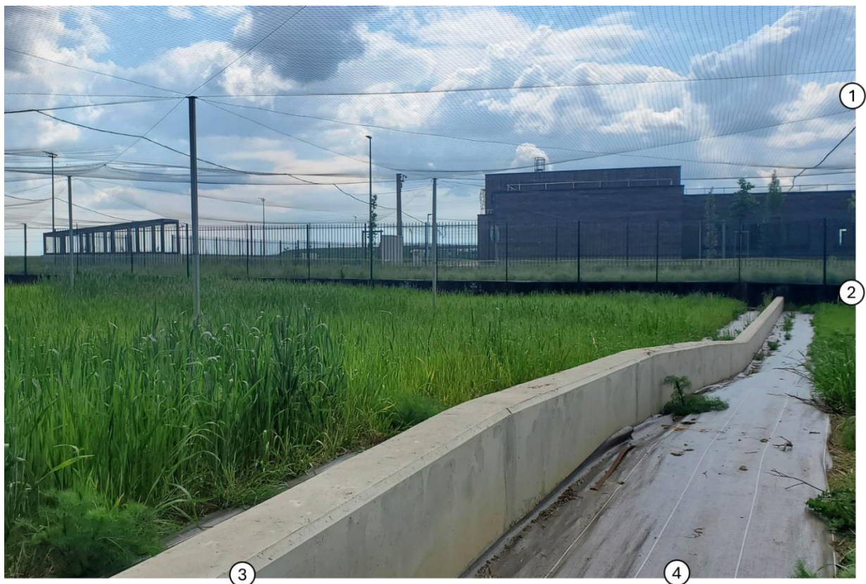
Figure 19 : Photographie de l'intérieur de l'enclos illustrant sa structure. On peut y voir un sous enclos semé en blé. Point d'intérêt : ① Filet anti-prédation, ② Enceinte profonde de 2 m, ③ Muret béton entre les sous-enclos et ④ toile de paillage.
