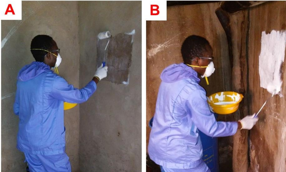
Figure 17 : Application d'un enduit (A) et de la peinture insecticide (B) sur les murs ( Source : Soma, 2018 ).
