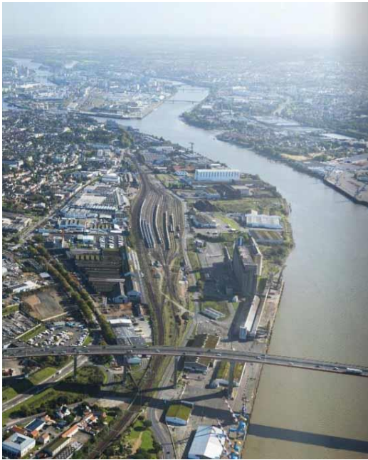
Figure 118, Vue aérienne du quartier du Bas-Chantenay. Source : Nantes Métropole
