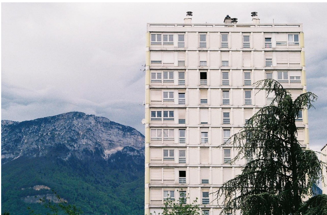
Figure 3, Immeuble de logements face au Vercors, Echirolles (Grenoble). Source : L. Garnier, 2022.
