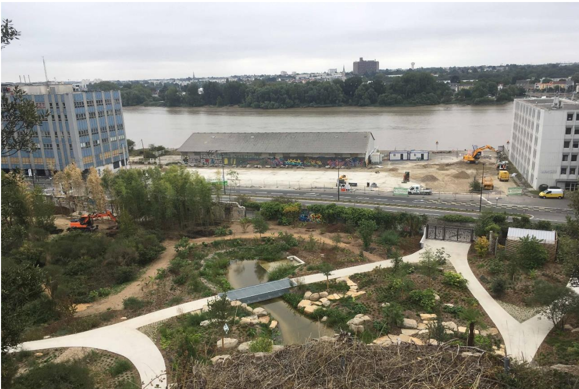
Figure 126, Vue du Jardin Extraordinaire en travaux depuis un belvédère construit à proximité du parc Marcel Schwob. Source : L. Garnier, 2019.
