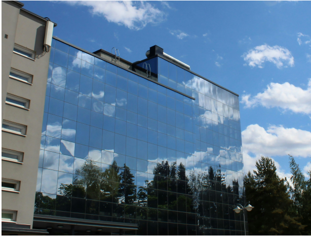
FIGURE 1.7 – Façade de bâtiment à réflexion spéculaire.
