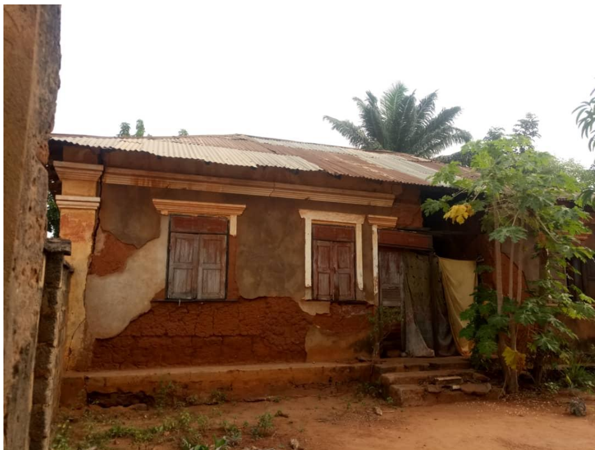
Figure 74 : Maison de style afro-brésilien en ruine
