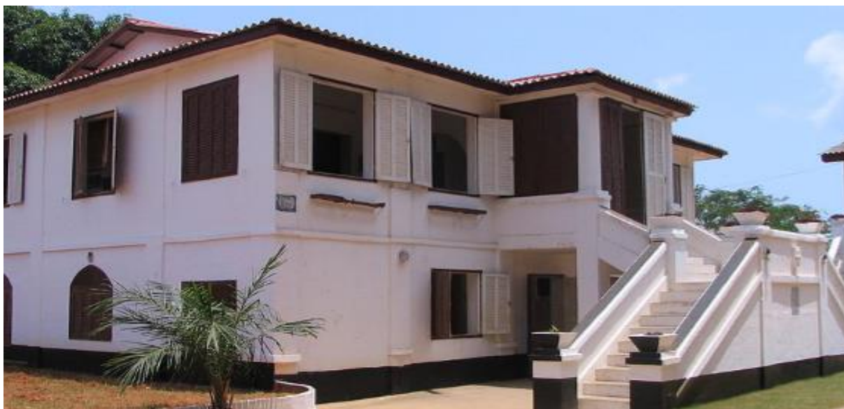
Figure 8 : Fort portugais de Ouidah (bâtiment principal)
