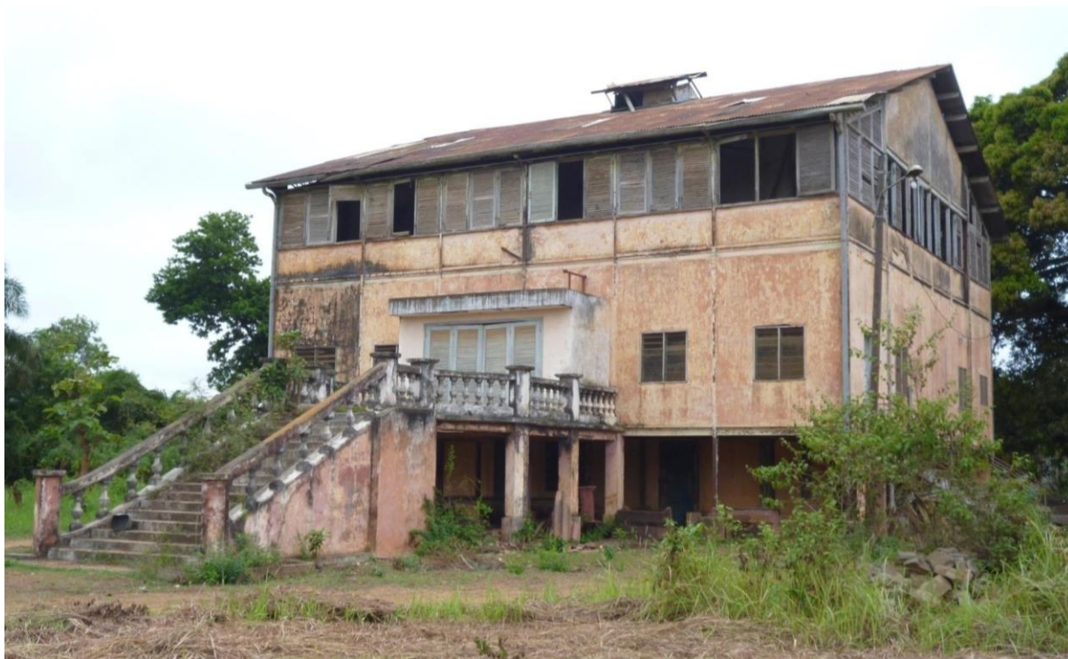
Figure 31 : Bâtiment colonial abandonné dans la ville de Ouidah
