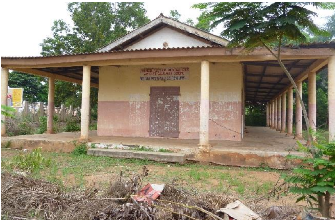
Figure 76 : Le bâtiment du tribunal colonial de Ouidah en 1993 et 2021
