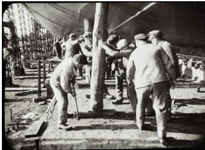
Les accores à abattre - © AHCNN/MHT
