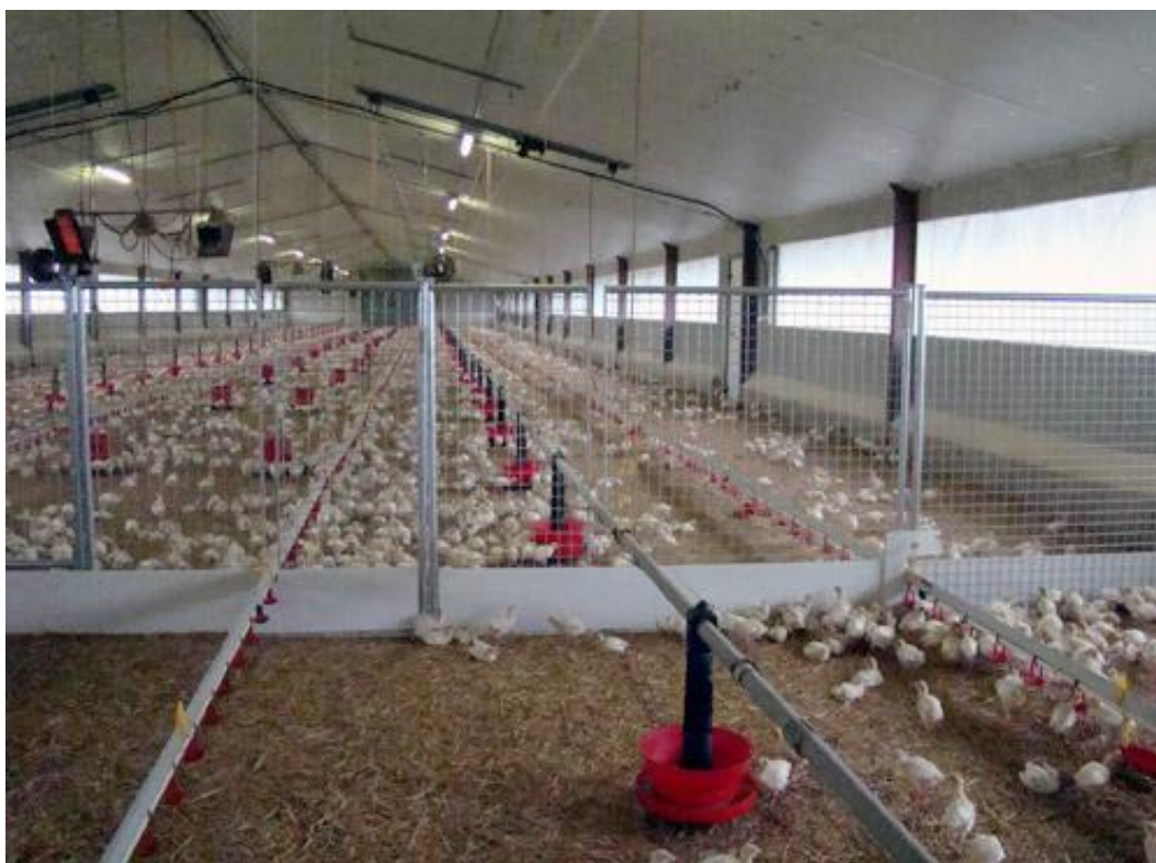
Figure 22 : Exemple de compartimentation dans un bâtiment de volailles
