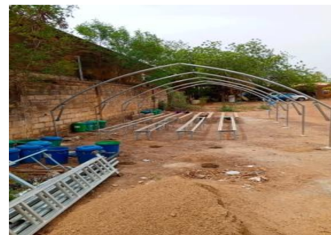
Pose de barre de fer de la serre constituant le support
