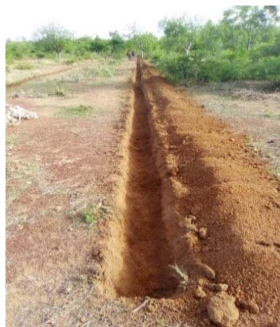
Figure 55. Photographie de la profondeur des tranchées
