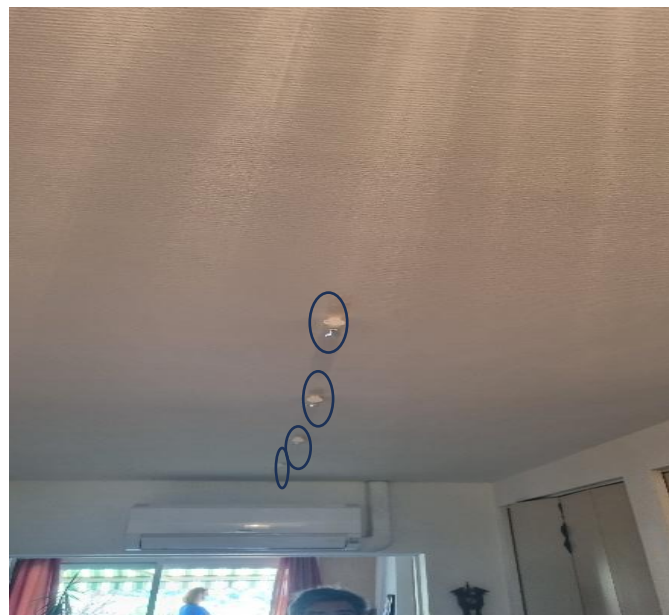
Figure 33. Dispositif de la ligne de marche : quatre capteurs PIR alignés au plafond (espacement 61 cm), permettant le calcul de la vitesse de marche sur une distance de 1,83 m.
