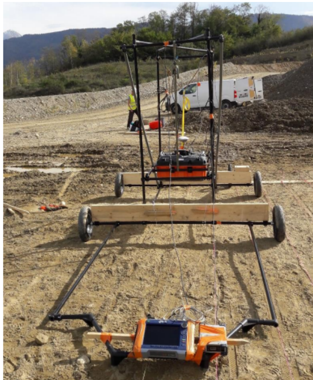
FIGURE 1.19 – Dispositif d'acquisition des radargrammes en élévation
