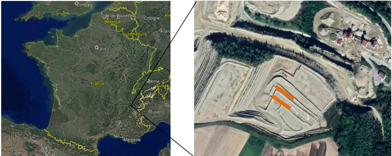
FIGURE 1.11 – Localisation de la zone d'étude : carrière de Barreaux (Isère)
