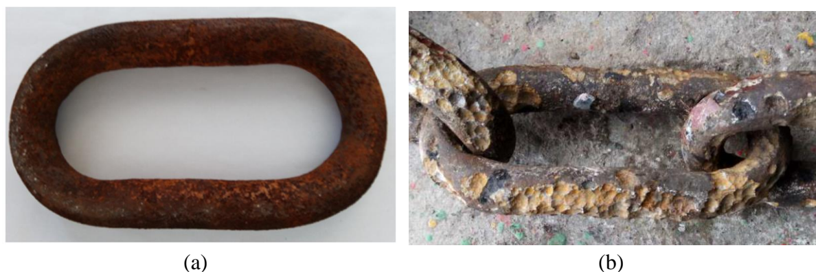
Figure I-41 – Mailles de chaînes utilisées pour l'ancrage de bouées de signalisation maritime. (a) Chaîne utilisée en mer, immersion permanente. La corrosion est généralisée : la surface est régulière et ne présente pas de cratères. (b) Chaîne utilisée en eau saumâtre, après 3 ans d'immersion. Observation de corrosion localisée prépondérante sous forme de multiples cratères.
