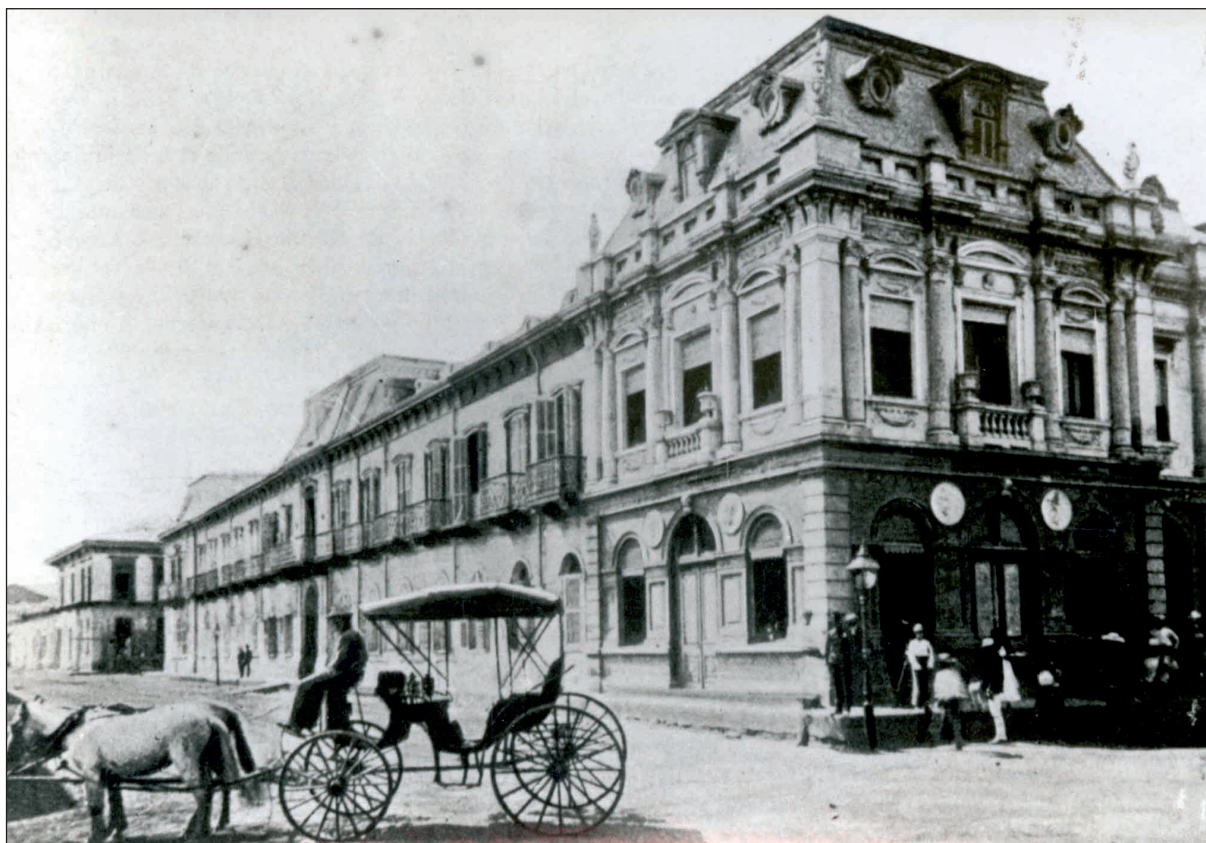
Photographie 22 - L'architecture de la fin du XIX e siècle était volontairement ostentatoire, faisant de la rue une scène pour le public de la capitale. Cette volonté de créer de l'espace public se traduit dans les préoccupations architecturales du palais national détruit en 1931 où les trottoirs qui le longent permettaient aux promeneurs d'éviter la poussière et les dangers de circulation des voies publiques encore en terre battue (Cliché : Archives de l'IHNCA).
