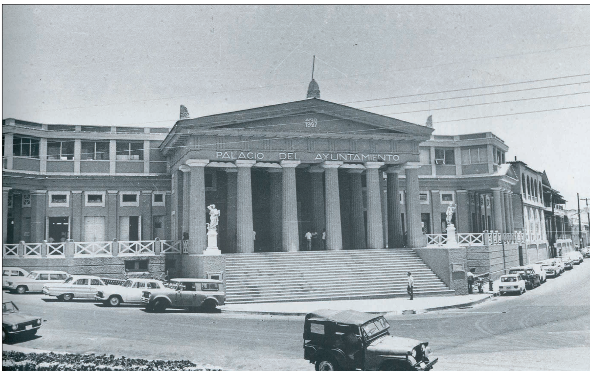
Photographie 5 - L'ostentatoire mairie de Managua, construite en 1927 face à la cathédrale, dans le centre colonial. Elle fut endommagée en 1931, réparée et totalement détruite en 1972 (Cliché : Archives de l'IHNCA).
