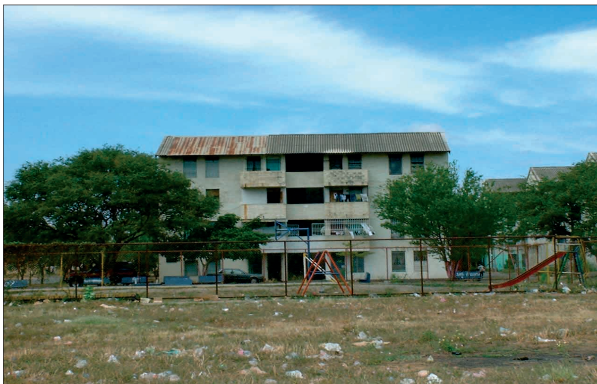
Photographie 8 - San Antonio. Au début des années 1980, le MINVAH développa la construction d'unités à plusieurs étages dans le centre de Managua pour pallier le déficit résidentiel hérité du somozisme, utilisant les techniques d'éléments préfabriqués et des matériaux industriels conventionnels. Certains logements durent finalement être achevés par les habitants eux-mêmes ou par des maçons aux moyens rudimentaires (Cliché : S. Hardy, 2002).
