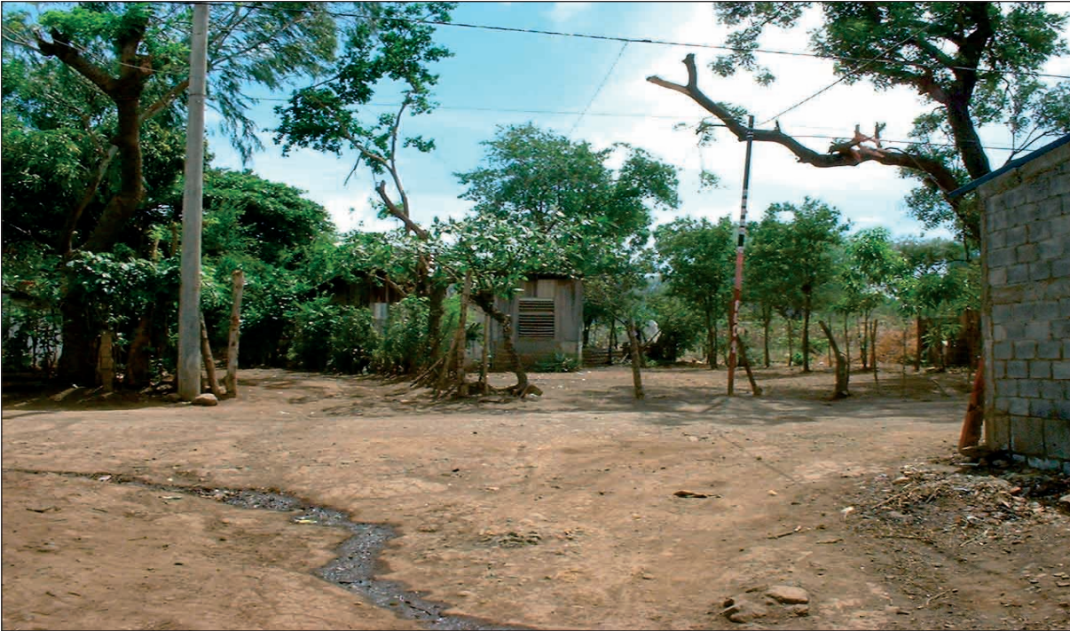
Photographie 20 - Le quartier de Germán Pomares se caractérise par l'absence de pavage des rues et d'infrastructures de drainage des eaux pluviales et des eaux résiduelles, par ses logements précaires. Mais, les habitants ont réussi à y faire circuler une ligne de bus, qui, en les reliant cahin-caha aux autres territoires urbains, leur évite la marginalisation (Cliché: S. Hardy, 2000).
