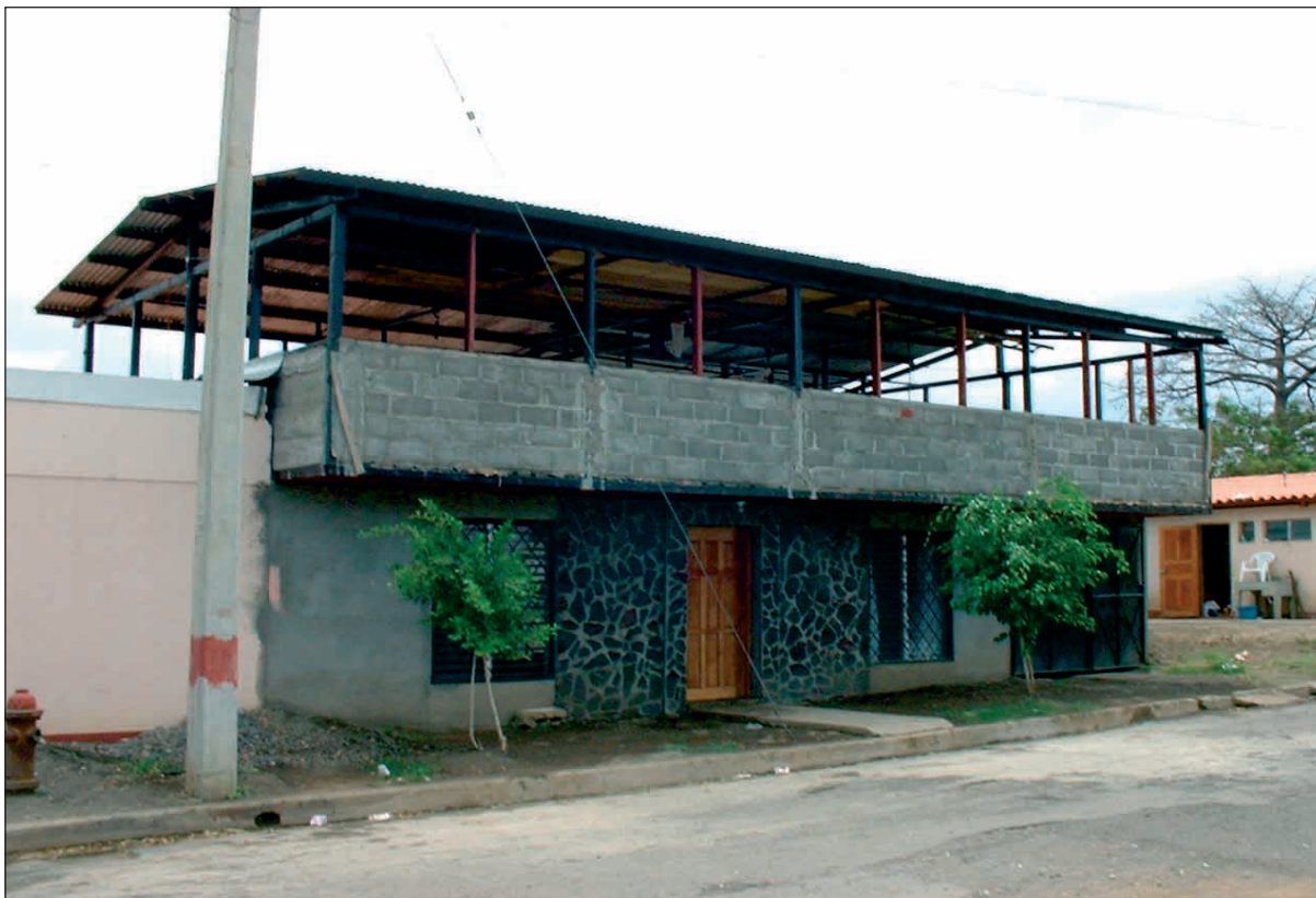
Photographie 14 - Immeuble construit dans le cadre d'un programme de l'Union européenne selon des normes parasismiques dans le quartier de San Sebastián en 2000. Un an plus tard, le propriétaire de l'immeuble avait déjà entrepris en toute illégalité des travaux d'agrandissement, rendant son logement dangereux en cas de séisme (Cliché: S. Hardy, 2001).
