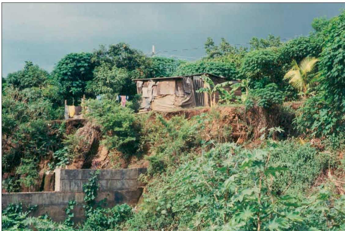
Photographie 2 - Les logements du quartier spontané de Grenada, face au quartier de Las Colinas pâtissent des aménagements contre les endommagements. Un mur de rétention construit en amont pour protéger Las Colinas favorise le sapement des bords d'un cauce qui met en péril un logement spontané (Cliché : S. Hardy, 2000).
