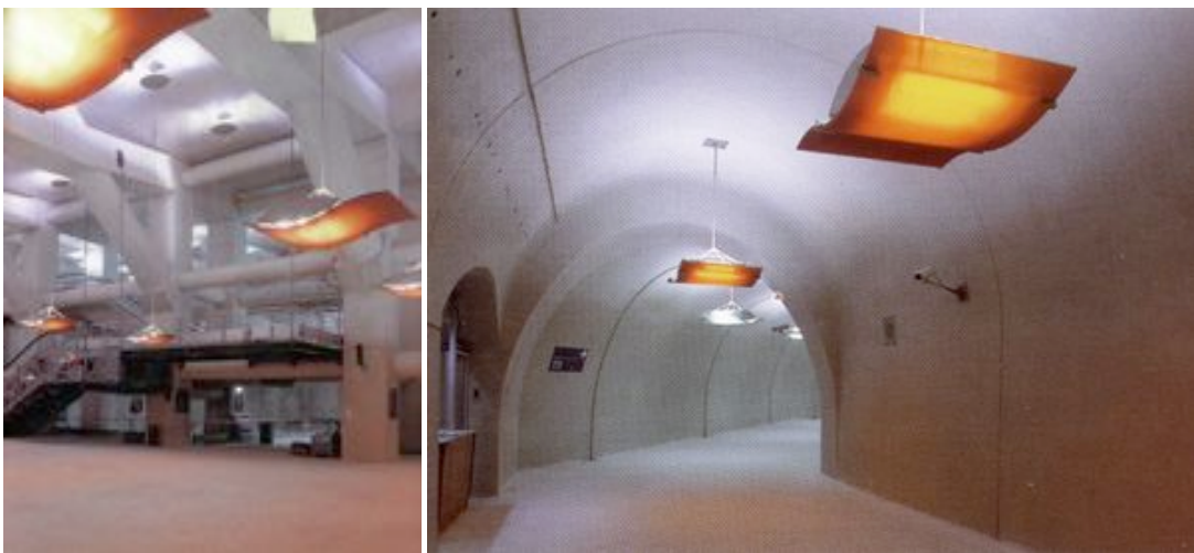
Figure 6 : Vue sur la salle inférieure et sur la sortie St Lazarre, Haussmann (Eole) - document AREP.
