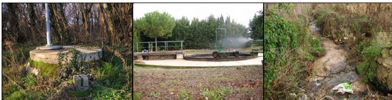
Figure 131. Captage du Pouget (C15) (à gauche) - Station d'épuration du Pouget (au milieu) - Ruisseau l'Aumède au point de rejet des effluents de STEP(à droite).
