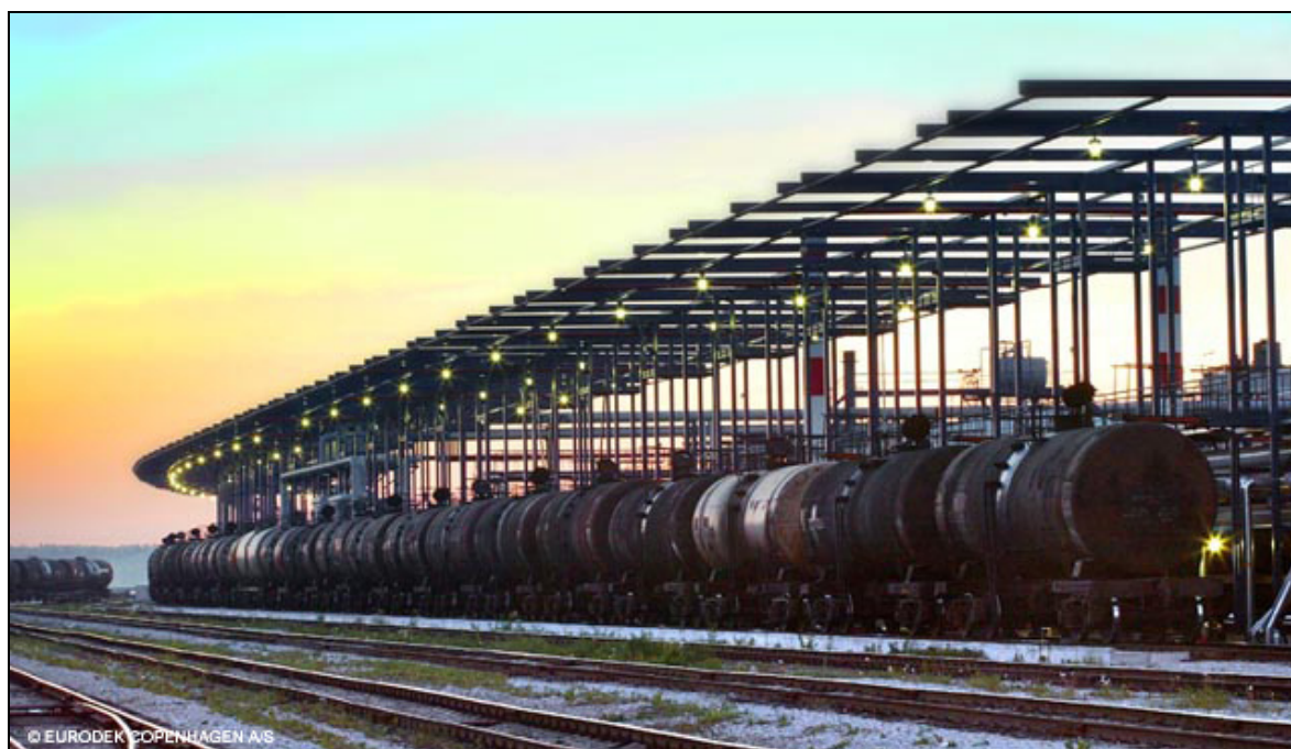
Figure 36 : Déchargement d'un train d'hydrocarbure à Muuga
