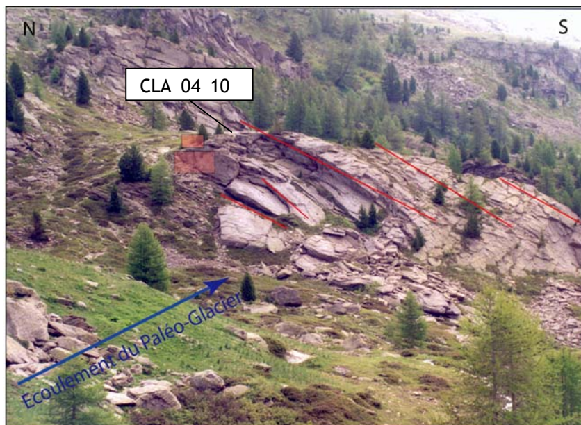
Figure C-94 : Eboulement de type B, développé à partir de la face amont des roches moutonnées (n°5).
