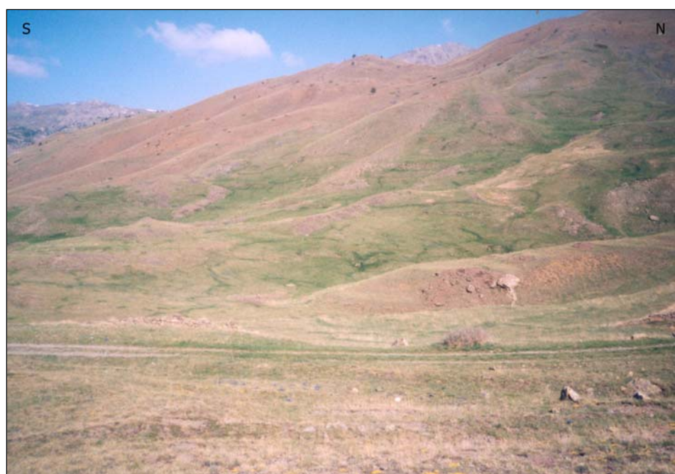
Figure C-87 : Fente d'arrachement en cours d'ouverture.
