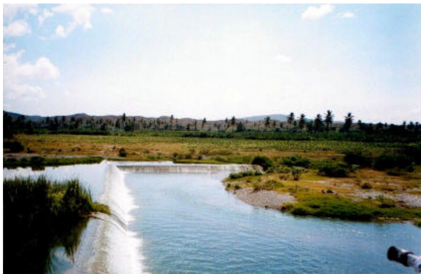
Photo 3 : barrage de dérivation Santana sur le fleuve Yaque del Sur.
