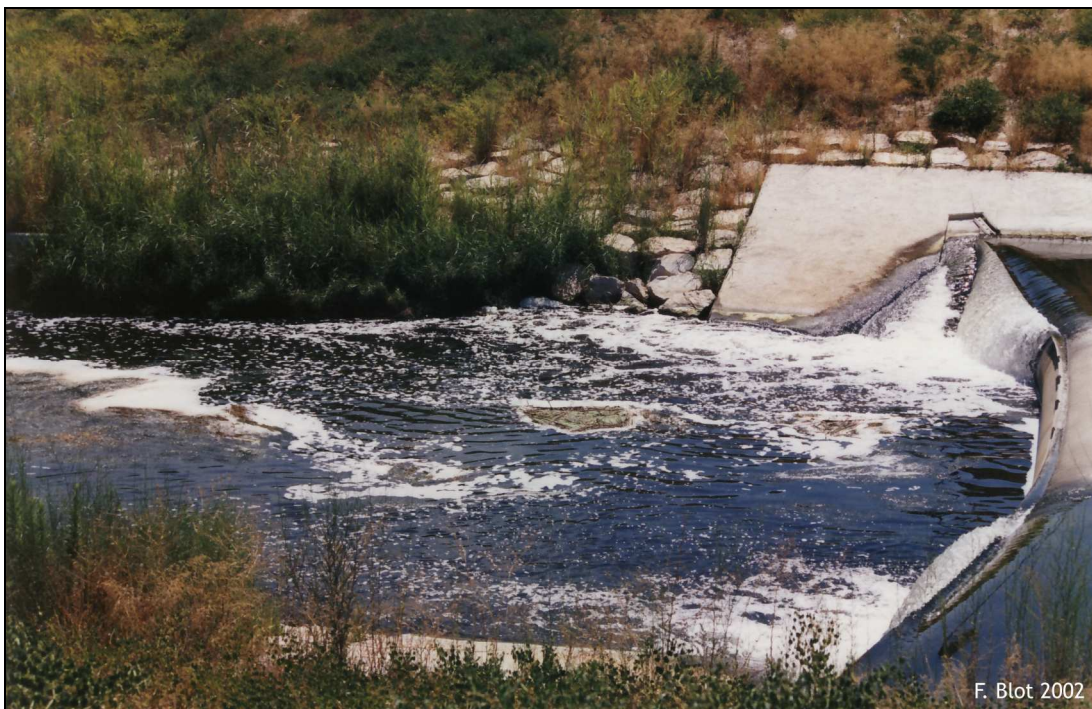
Figure 34 – Le Segura dans la Vega baja
