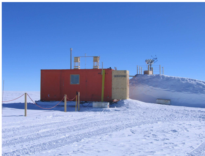
FIG. A.1: Site "propre" de la station franco-italienne Concordia : shelter Vitale (Janvier 2006).
