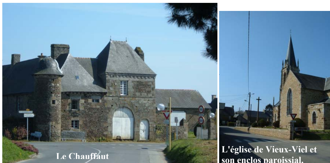
Fig.9 : vues du Chauffaut à Pleine-Fougères et de l'église de Vieux-Viel
