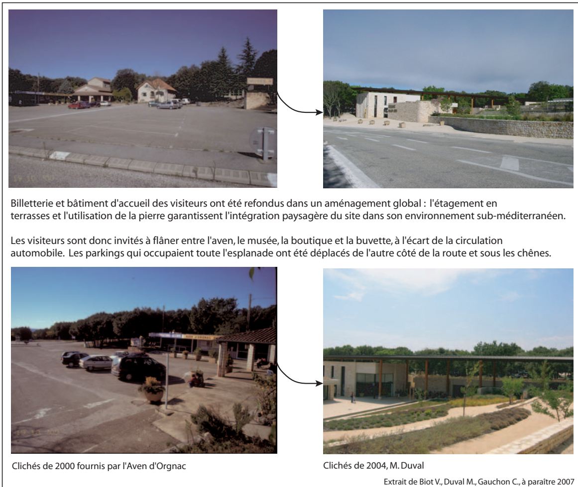
Figure II.30 : Les aménagements en surface réalisés dans le cadre de l'Opération Grand Site (2003)
