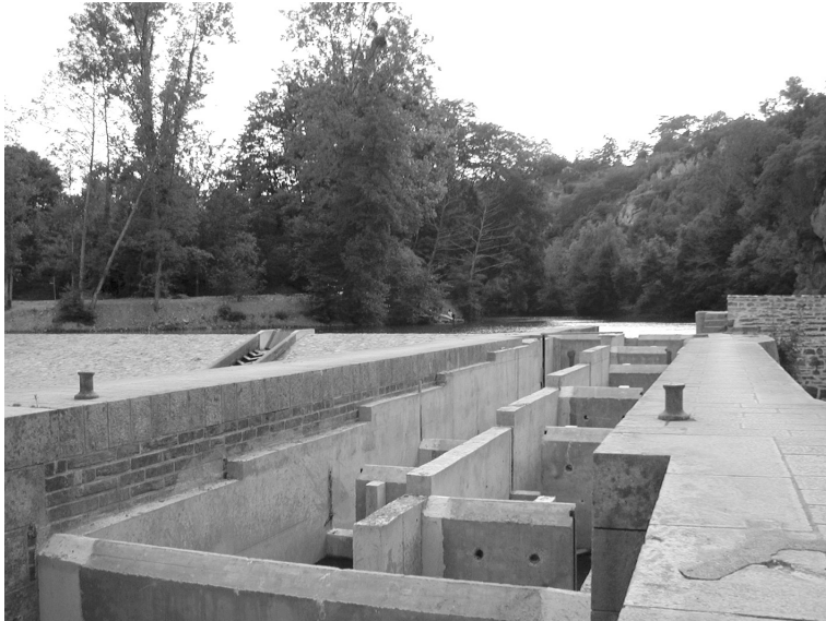
Photos 35 et 36 : Les franchissements piscicoles
