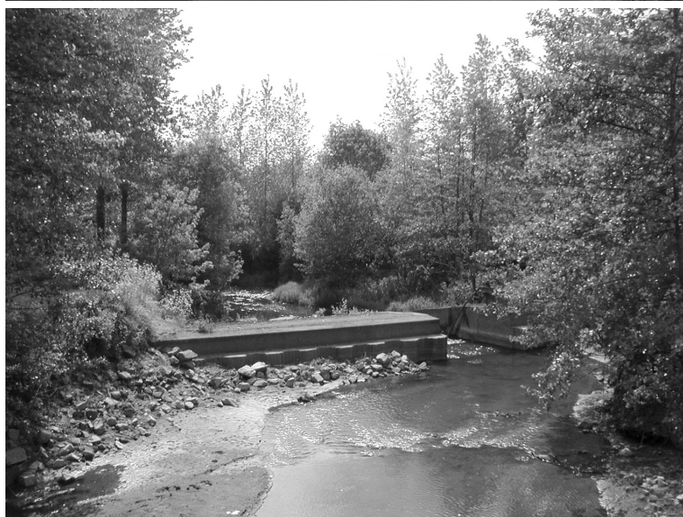
Photos 40 et 41 : L'expérience d'abaissement du plan d'eau de la Motte à Mouzillon, Vues amont et aval (clapet abaissé)
