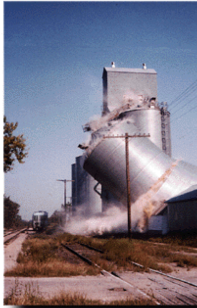
FIG. 2.1: Effondrement accidentel d'un silo sous l'effet de contraintes mal maîtrisées.
