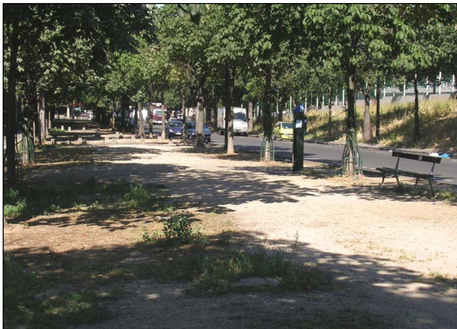
Figure n°61. La rue L. Pasteur Valléry-Radot, près de la Porte de St-Ouen (18 em arrondissement) : un revêtement en mauvais état (photo : C. Pouessel, juillet 2006)
