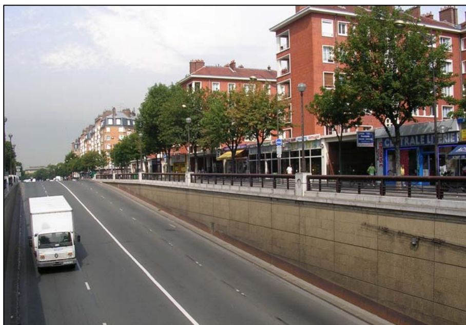
Figure n°62. La trémie du boulevard Ney dans le 18 em arrondissement de Paris (photo : C. Pouessel, juillet 2006)
