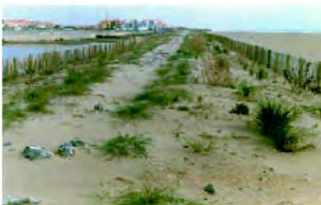
Cordon dunaire recréé sur le haut de la plage de Saint-Pierre-la-Mer - mai 2003.
