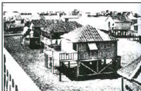
Dans les années 1930, les éléments architecturaux du chalet sont définis : murs en lattes de bois, pilotis, terrasse, et toit à deux ou quatre pentes en tôle.
