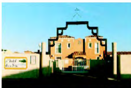
Portail d'entrée monumental et sécurisé de la Résidence "L'Oustal des Mers" dans le quartier des Ayguades à Gruissan - mai 2002.
