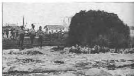
Travaux de remblaiement de la zone 1 avec la drague Sidhawn de la Compagnie Mouritzen.
