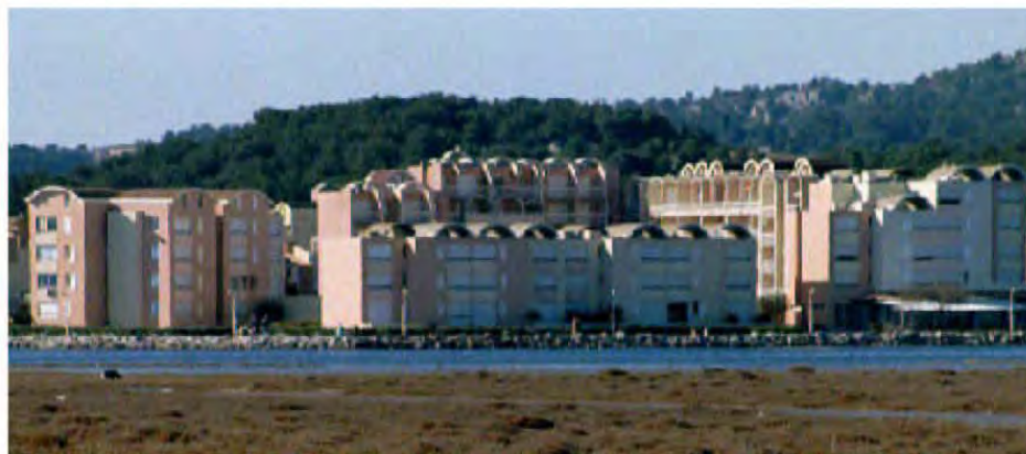
Le "voûtain" imaginé par Raymond Gleize coiffe les immeubles de 3 à 5 étages et assure ainsi l'unité architecturale de la marina de Port-Gruissan. Photo VAB.
