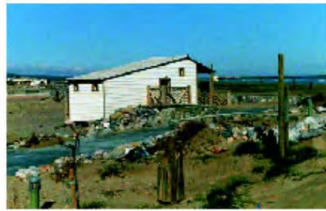
Des claustras en bois viennent donner un ton "naturel" à la nouvelle ligne d'engrochements à Gruissan-Plage - mai 2002.
