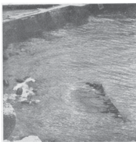
19.29. Quai de l'îlot du château de la Mer (POIDEBARD et LAUFFRAY, 1951).
