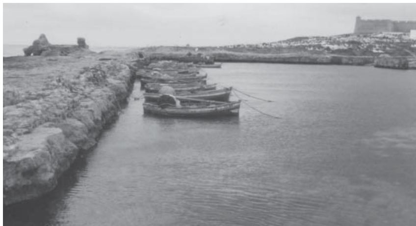
66.10. La paroi Sud orientale du bassin et les petites embarcations de pêcheurs qui s'y amarrent encore. On notera également l'encoche d'érosion dans la paroi au niveau relatif actuel de la mer.
