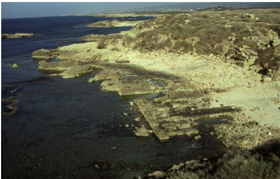
32.20. Vue du quai du Bronze récent depuis le Sud-est.
