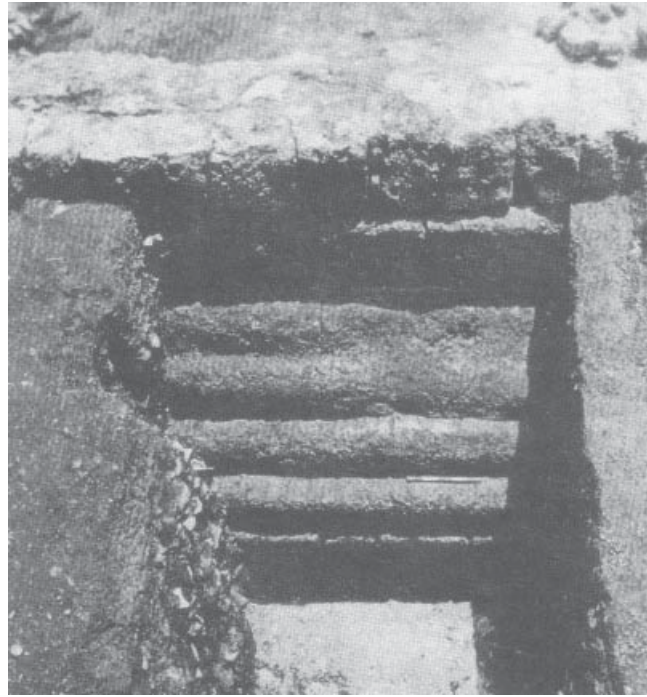
80.14. Vue du quai de l'îlot de l'Amirauté (HURST, 1980a).
