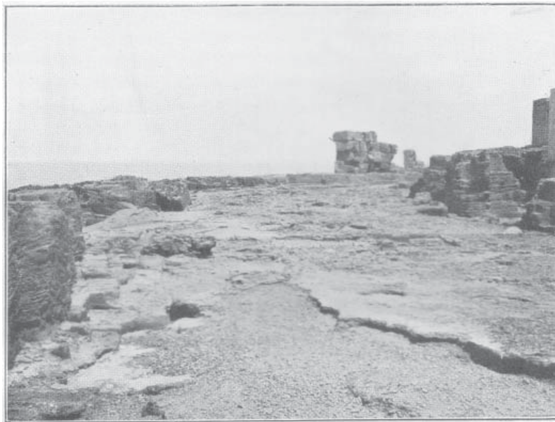
01.14. Esplanade à l'Ouest de l'île. A gauche, le soubassement taillé de l'enceinte ; au fond la portion à cinq assises et à droite, le front de taille (SAVIGNAC, 1916).
