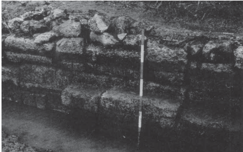
106.25. Paroi construite au Nord du bassin, légèrement incurvée, avec un rebord au pied de l'ouvrage.
