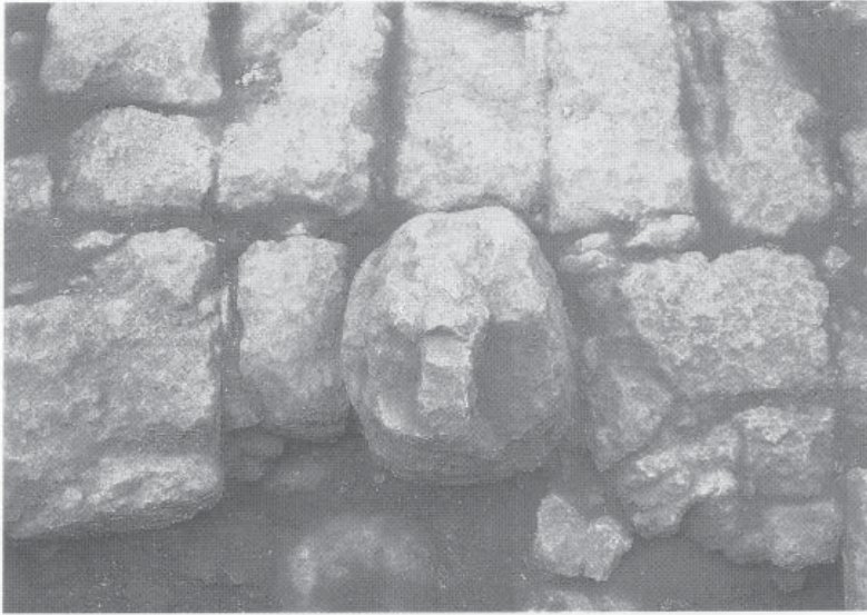
17.16. Sondage Bey 039. Borne d'amarrage du niveau I (ELAYI et SAYEGH, 2000). Vue de dessus.
