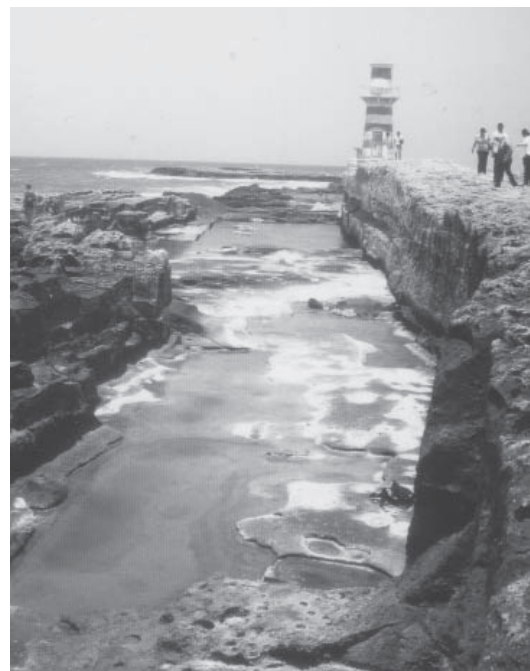
19.63. Le chantier d'exploitation B sur l'île de Ziré entre les deux bras du mur de mer en 2003. Vue vers le Nord.
