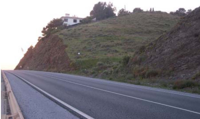
158.03. Une des collines de Chorreras profondément entaillée par la route côtière.
