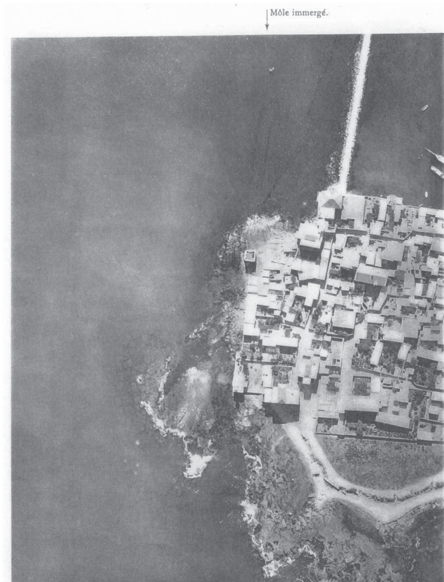
23.21. Photographie aérienne verticale de la pointe Nord-ouest de la presqu'île de Tyr sur laquelle on distingue les traces du môle submergé (POIDEBARD, 1939).
