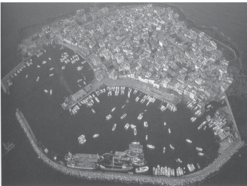
01.03. Vue aérienne oblique depuis le Nord-ouest de l'île d'Arwad dans les années quatre-vingt dix (BINST, 1999).
