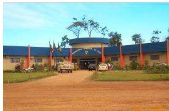
Photo 1.21 : le siège de la municipalité de Vera (prefeitura) en 2002. La nouvelle construction en dur en périphérie de la ville a remplacé la construction en bois du centre NDVi 2 , mai 2002
