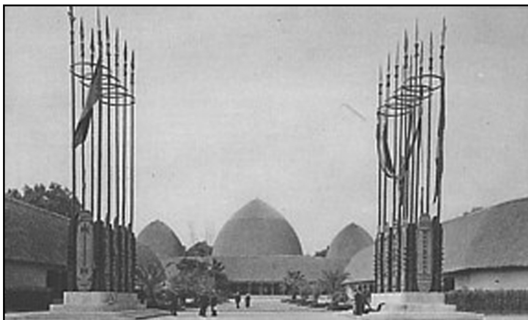
Document 1. Section coloniale belge (vue d'ensemble depuis le portique d'entrée)
