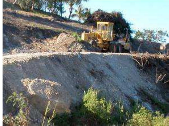
Photographies 58 et 59 : Travaux au col d'Amoss et dans le village de Ouégoa. La présence de roches contenant des minéraux fibreux constitue un danger pour les travailleurs et les populations aux alentours (Photos auteur)
