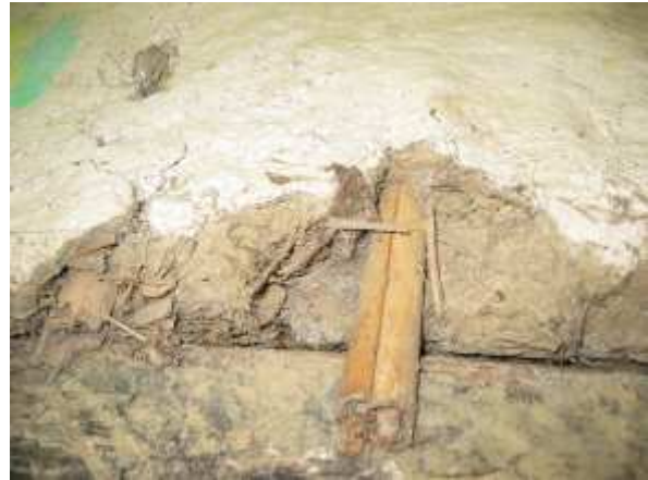
Photographies 95 et 96 : Maison recouverte de pö trémolitique. Les photographies montrent le mélange paille-ossature en bois de l'habitat et la dégradation du mur. Tribu de Montfaoué (Poya) (Photos Christian Picard)
