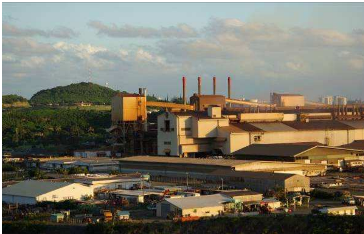
Photographie 93 : Le complexe industriel de la SLN. La présence d'amiante y était avérée. Il a été retiré des installations au cours des dernières décennies (Photo Eric Beaumont)
