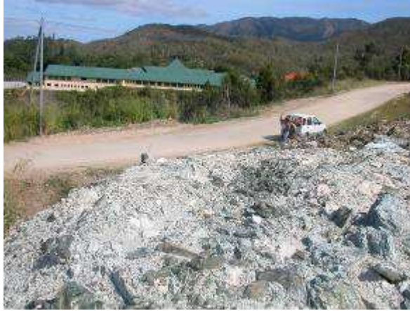
Carrière ouverte lors de l'ouverture de la piste d'accès au collège
