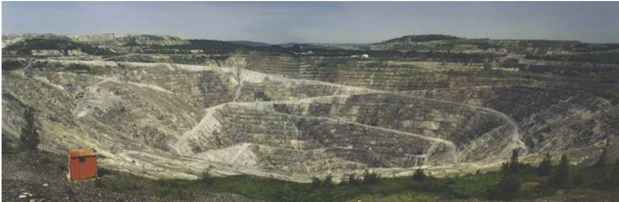
Photographie 2 : Mine d'amiante Jeffrey, à Asbestos, Canada (Photo Nichole Ouellette)
