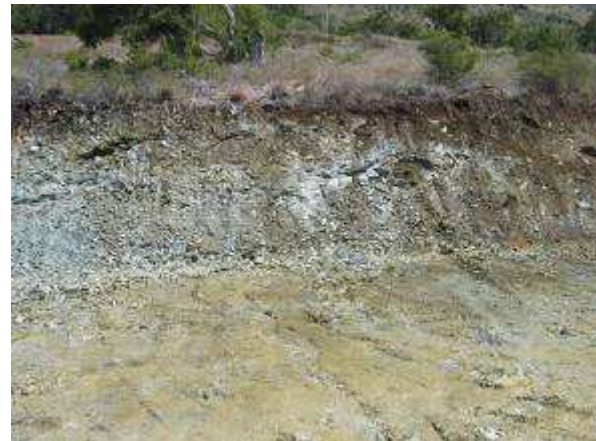
Photographies 62 et 63 : Des chantiers de constructions sont en cours de réalisation à la tribu de Tiendanite et de Ouaré. Les travaux libèrent des fibres de trémolite dans l'air (Photos auteur et Christian Picard)
