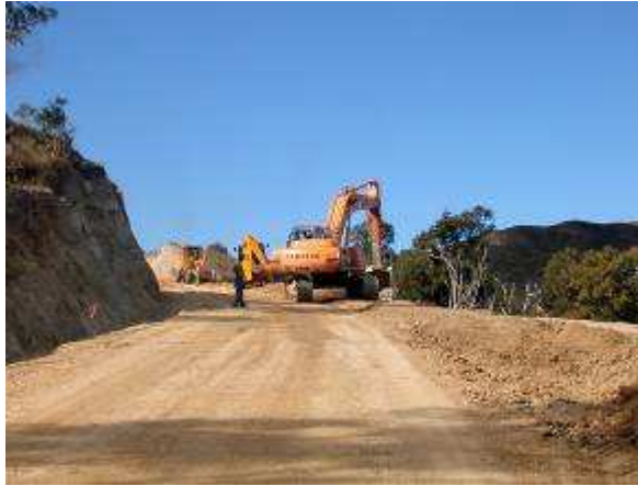
Photographies 58 et 59 : Travaux au col d'Amoss et dans le village de Ouégoa. La présence de roches contenant des minéraux fibreux constitue un danger pour les travailleurs et les populations aux alentours (Photos auteur)
