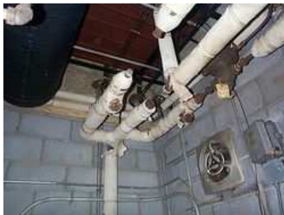
Photographies 90, 91 et 92 : Le flochage est plus fréquemment rencontré dans les établissements recevant du public et les immeubles de grande hauteur en raison des exigences de la protection incendie. Toiture en amiante fibrociment. Calorifugeage (Photos INRS)
