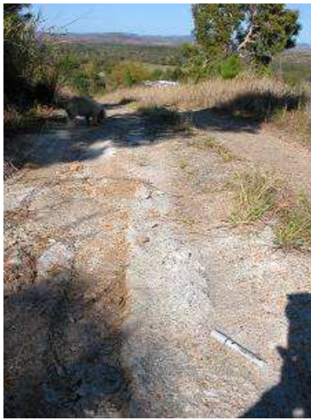
Chemin d'accès au château d'eau
