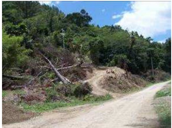
Photographies 60 et 61 : Des travaux d'électrification dans la vallée de la Hienghène mettent à jour des occurrences de roches trémolitiques. Outre le risque d'exposition immédiat pour les travailleurs, le matériau étalé sur le sol constitue une source de nuisance pour les populations voisines (Photos auteur et Emmanuelle Marquette)
