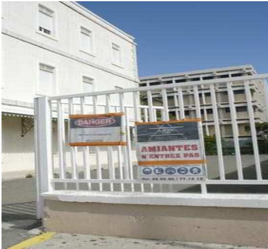
Photographie 112 : Désamiantage du Collège Beaudoux – Nouméa – en 2006, sous l'égide de la province Sud (Photo Les Nouvelles calédoniennes)
