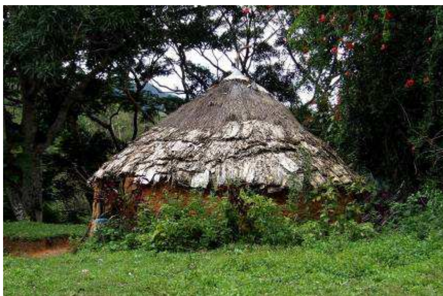
Photographie 94 : Exemple d'une case ronde à la tribu de Haut-Coulna – commune de Hienghène - Les murs sont en argile alors que « traditionnellement » ils étaient en végétal. Le toit est recouvert de peau de niaouli et de paille (Photo auteur)
