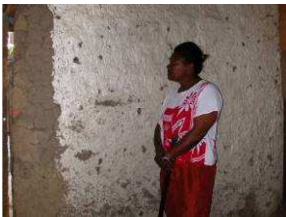
Photographies 97 et 98 : Pö trémolitique sur des murs d'habitation. Pö ocre - Tribus de Bondé - Commune de Ouégoa - (Photos auteur)
