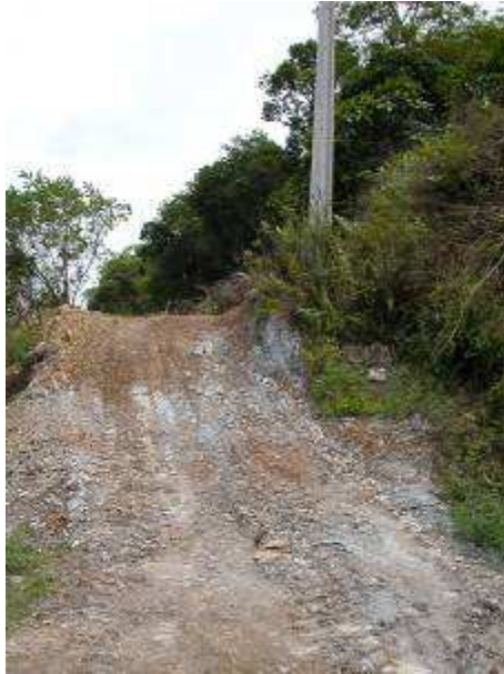
Photographies 60 et 61 : Des travaux d'électrification dans la vallée de la Hienghène mettent à jour des occurrences de roches trémolitiques. Outre le risque d'exposition immédiat pour les travailleurs, le matériau étalé sur le sol constitue une source de nuisance pour les populations voisines (Photos auteur et Emmanuelle Marquette)
