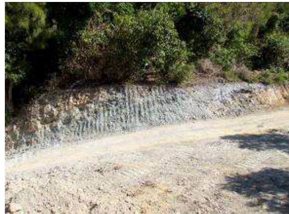
Photographies 64 et 65 : Les travaux d'adduction en eau potable financés par la commune de Hienghène et l'Etat ont créé un affleurement de roches contenant de la trémolite - Tribu de Ouayaguette (Photos auteur)
