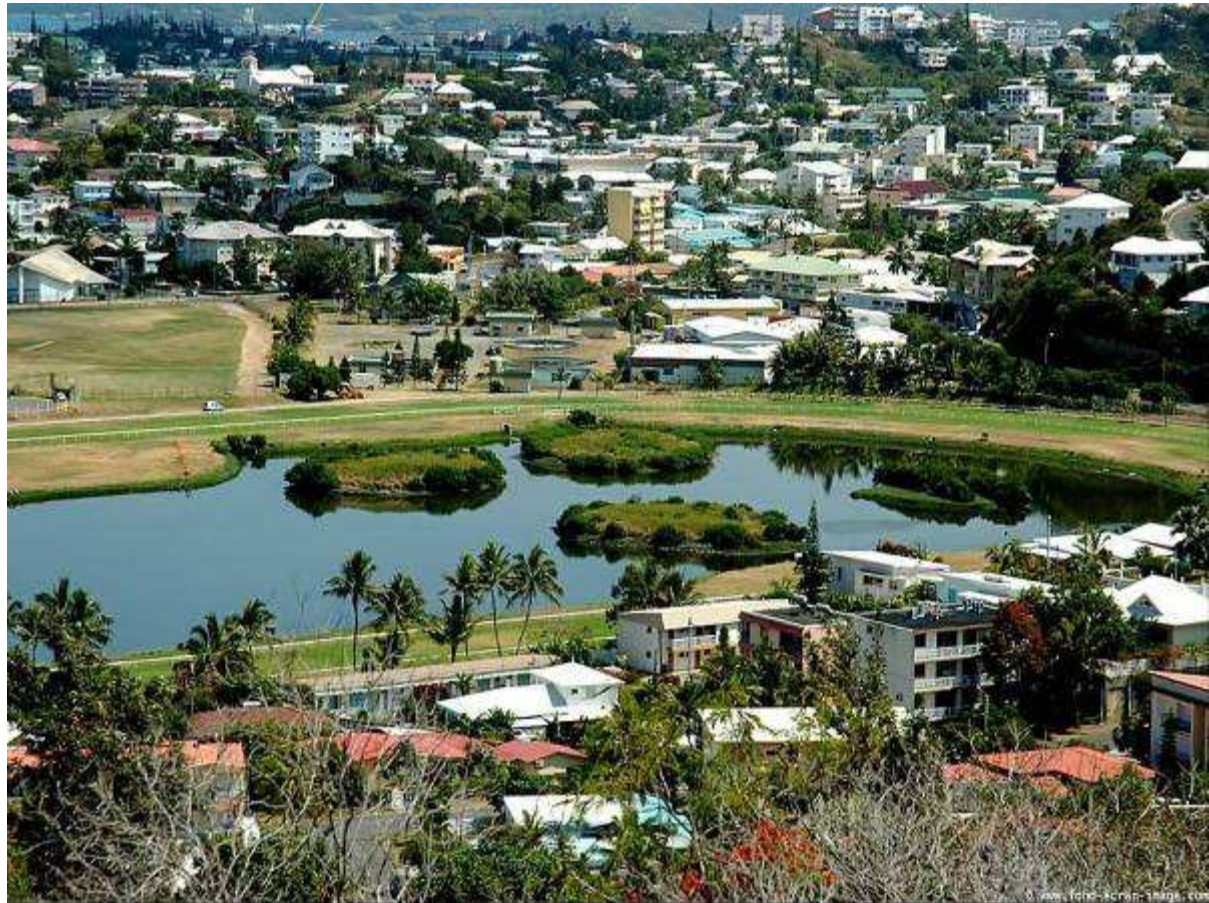
Photographies 87, 88 et 89 : Nouméa est construit sur le modèle des villes de la Riviera française. Certaines constructions comportent de l'amiante manufacturé (Photos auteur)
