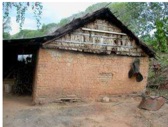
Photographies 97 et 98 : Pö trémolitique sur des murs d'habitation. Pö ocre - Tribus de Bondé - Commune de Ouégoa - (Photos auteur)
